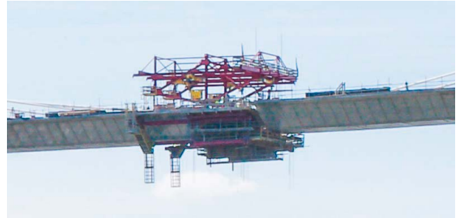
Figura 21. Flecha diferencial en voladizo de vano 4.
