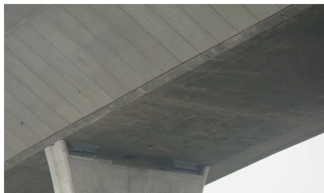
Figura 6. Foto del intradós del puente.
