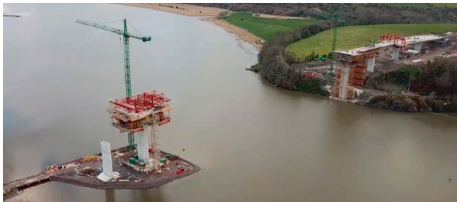
Figura 1. Cruce del río durante la construcción (P4 central -derecha- y P3 lateral -izquierda-).
