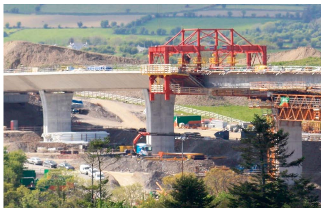
Figura 12. Carro de alas sobre vano 3.
