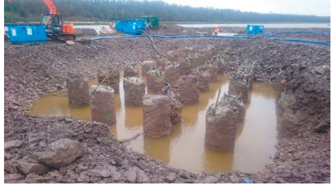
Figura 7. Pilotaje de la pila central.
