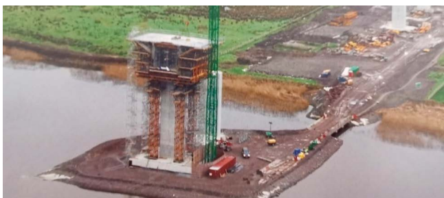
Figura 17. Dovela "0" sobre pila 4. Construida sobre cimbra.
