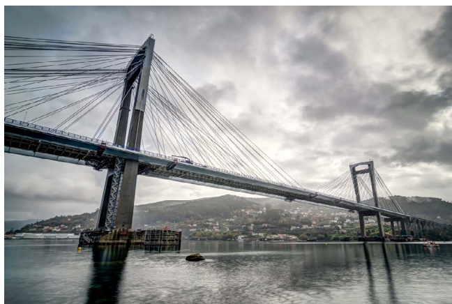
Figura 1. Vista del puente ampliado.
