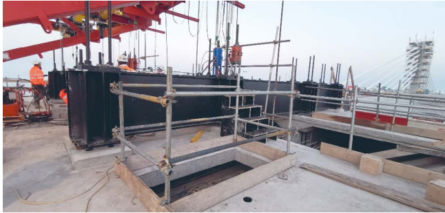
Figura 23. Alzado del puente durante el hormigonado de la última dovela de la pila 4.
