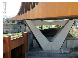
Figura 39. Puente para AVE c/Comercio (Madrid).
