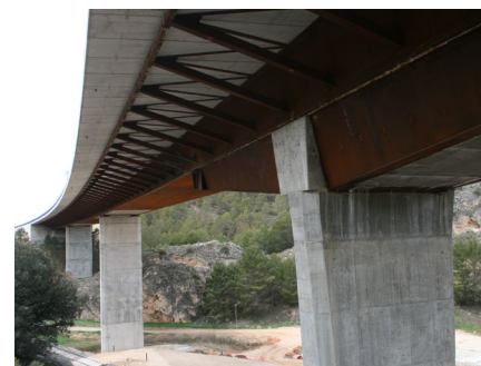
Figura 29. Viaducto del estrecho de Paredes en la A-40 (Cuenca).
