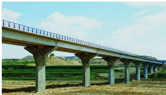
Figura 52. Viaducto de La Clamor, L.A.V. Madrid-Barcelona.
