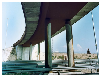
Figura 38. Puentes E-23 y E-25 (Valencia).
