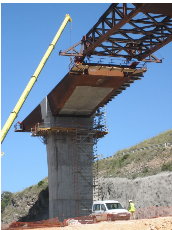
Figura 60. Llegada del tramo empujado al ábaco mixto.
