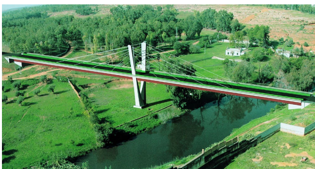
Figura 21. Proyecto puente de Alcalá de Guadaíra (Sevilla).
