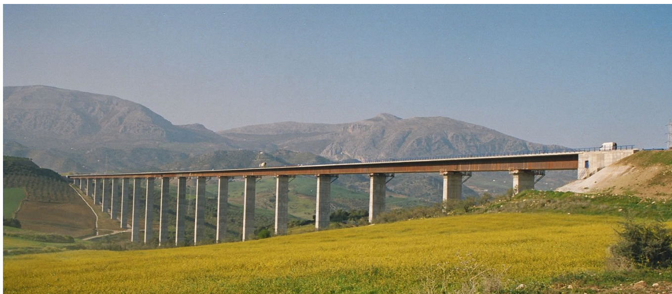
Figura 31. Viaducto de las Piedras (Málaga).
