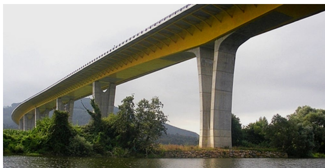
Figura 16. Viaducto del río Nalón (Asturias).
