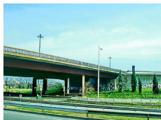
Figura 37. Puente de Sant Adria (Barcelona).
