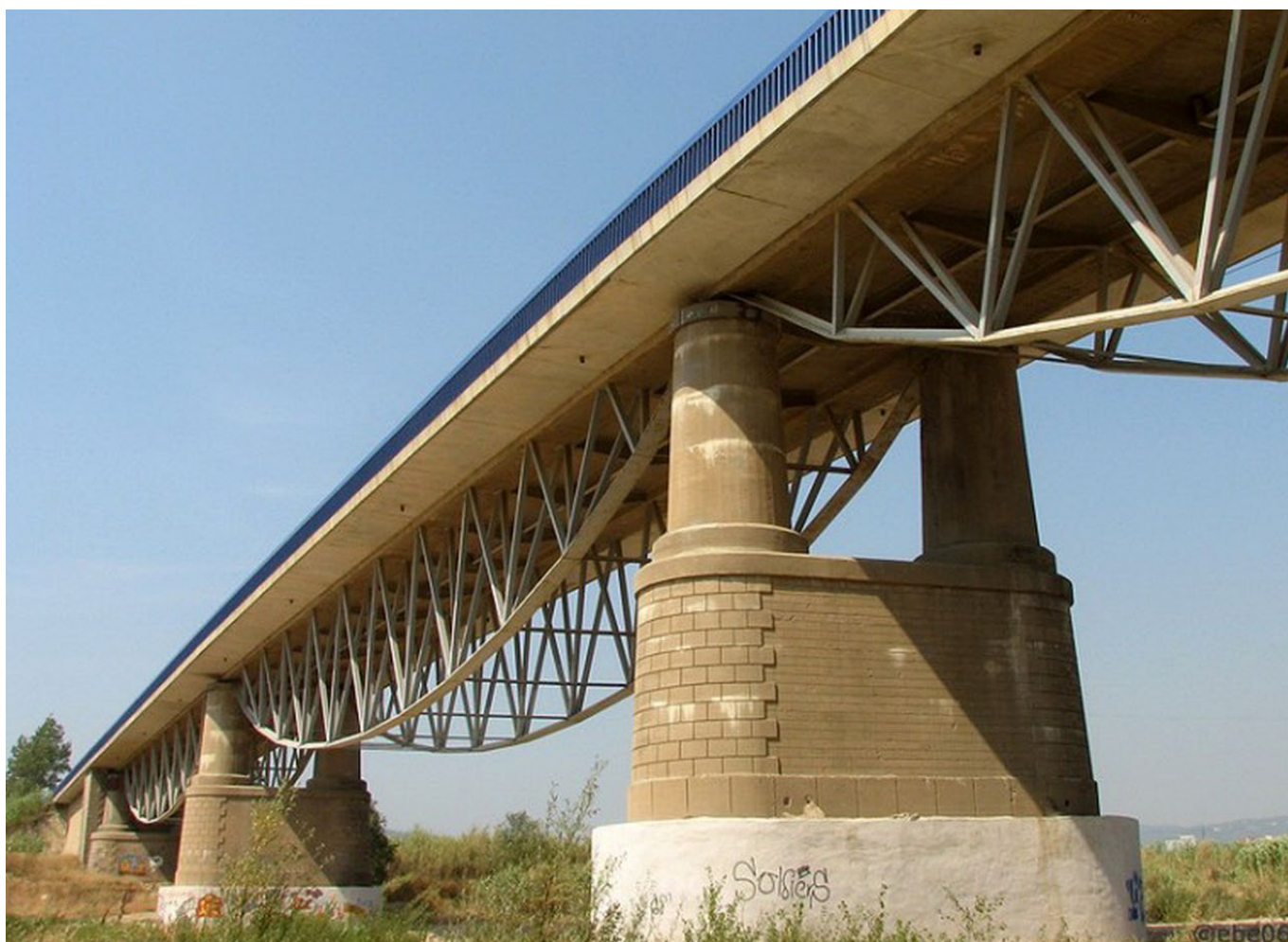
Figura 57. Puente de Tordera (Gerona). Vista inferior del puente ensanchado y rehabilitado.
