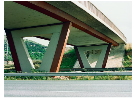
Figura 49. Paso superior con cajón muy ancho sobre hormigón.
