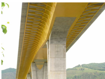
Figura 30. Viaducto del Nalón (Asturias). a) Vista general inferior. b) Fondo del cajón en pilas principales. c) Fondo del cajón en pila tipo.
