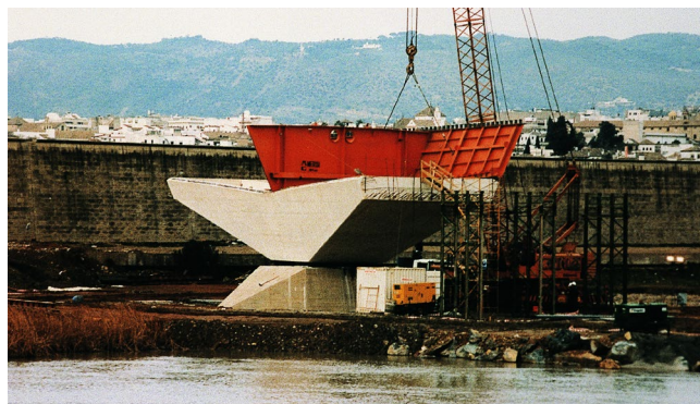
Figura 53. Ejecución de la zona de célula elástica.
