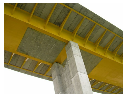
Figura 30. Viaducto del Nalón (Asturias). a) Vista general inferior. b) Fondo del cajón en pilas principales. c) Fondo del cajón en pila tipo.
