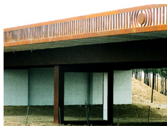
Figura 33. Paso sobre la A-2 c/ Marqués de Suanes (Madrid).
