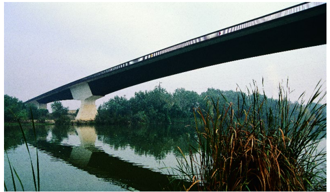
Figura 12. Puente de Tortosa (Tarragona).
