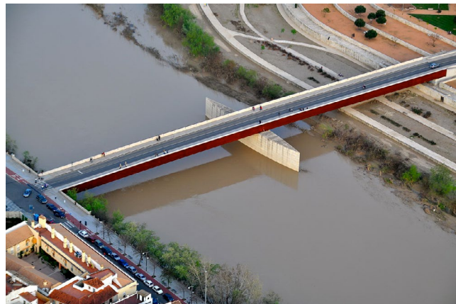
Figura 61. Puente de Miraflores (Córdoba).
