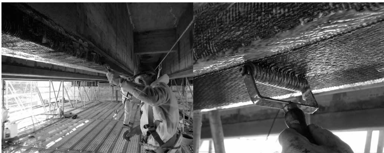
Figura 18. Etapas de la ejecución del refuerzo con Foreva® TFC
