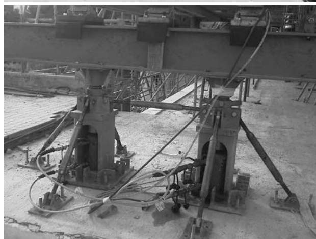
Figura 10. Montaje de la celosía y cilindros hidráulicos en estribo
