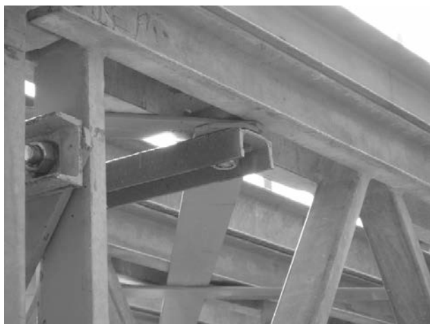
Figura 9. Cordón reforzado de las celosías
