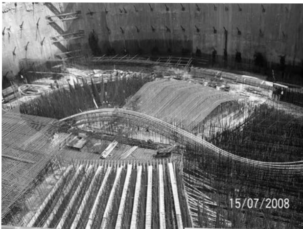
Figura 13. Vista general de la cimentación previa a la segunda fase de hormigonado
