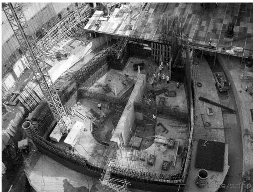
Figura 12. Vista general de la cimentación de la torre
