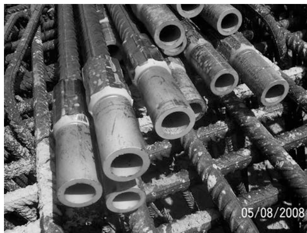
Figura 16. Empalmes mecánicos de la armadura vertical
