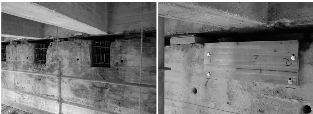
Figura 22. Colocación de armado tras extracción de biela, y encofrado fenólico tipo
