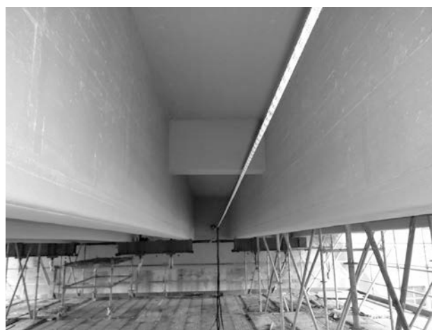
Figura 20. Estado final de tablero tras la protección
