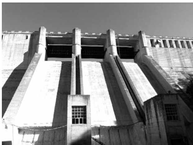
Figura 1. Vista general de la presa
