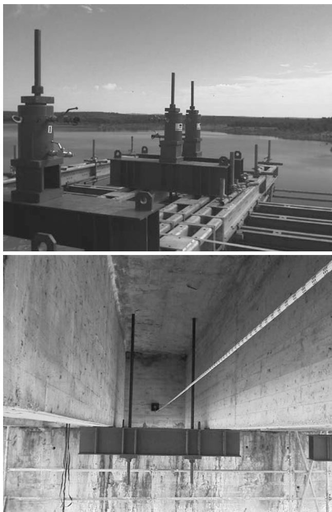
Figura 12. Sistema de barras y cilindros hidráulicos para apeo del tablero superior e inferior respectivamente
