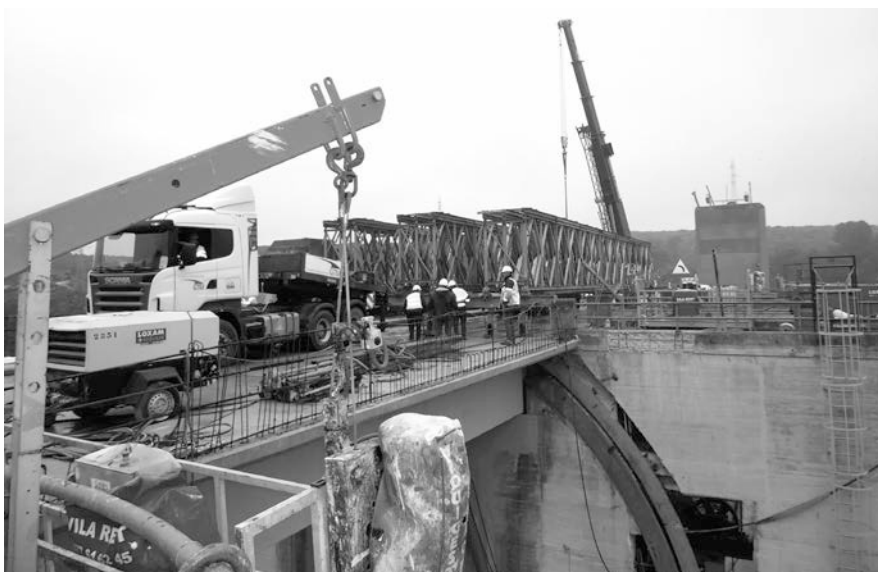
Figura 24. Transporte de celosía con grúa y camión
