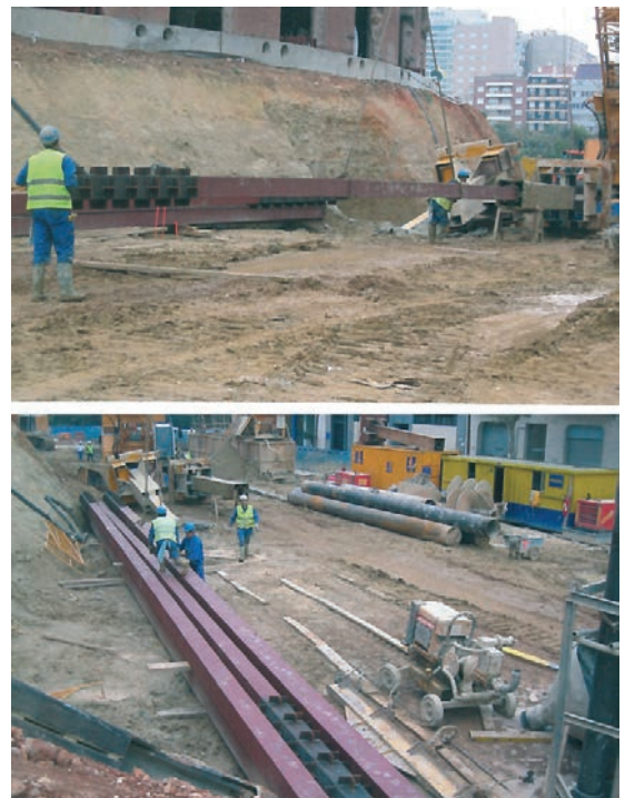
Figuras 11 y 12. Croquis de pilote-pilar y vistas de pilares metálicos Figures 11 & 12. Plunge columns and views of steel supports
