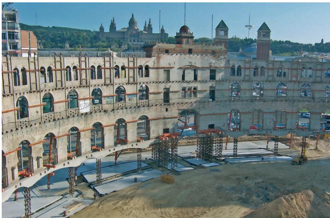
Figura 24. Fachada apoyada sobre castilletes Figure 24. Façade resting on turrets
