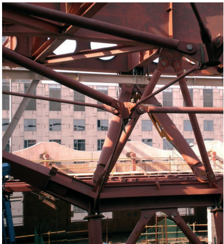
Figuras 49 y 50. Detalle 3D y vista del encuentro de barras (ramas) de pilar arbóreo Figures 49 & 50. 3D detail and view of the meeting point of tree-support bars (branches)
