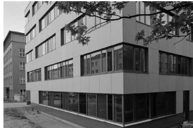
Figura 22. Placas de fachada de hormigón armado con textiles en el campus de la TU Dresden [11]
