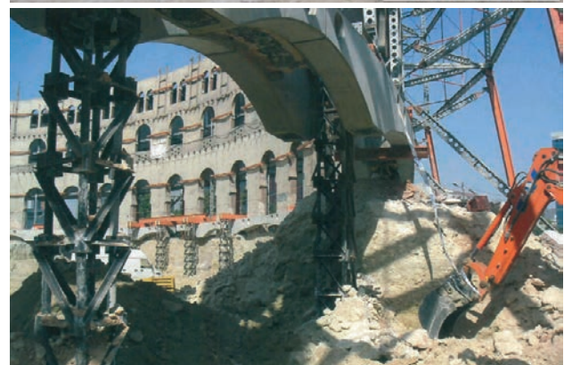
Figuras 22 y 23. Excavación del caballón y arriostramiento de los micropilotes
