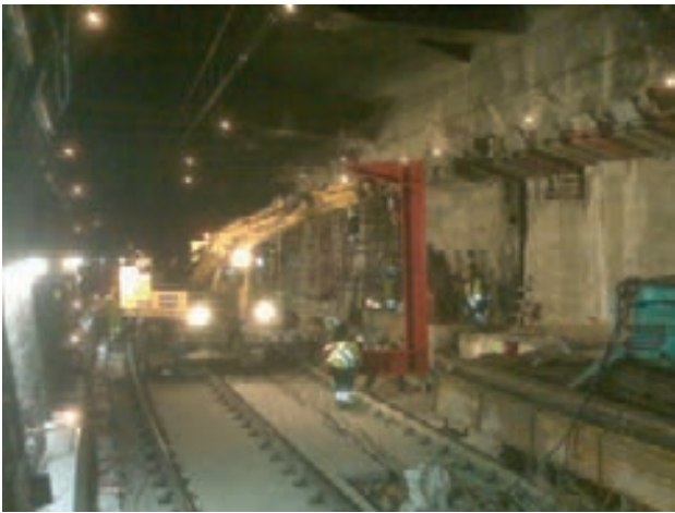
Figura 18. Colocación de la estructura metálica en C
