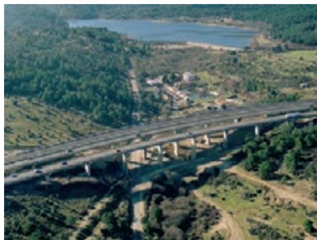
Figura 3. Viaductos de La Jarosa (3 calzadas separadas) antes de la intervención. De abajo a arriba: calzada sentido La Coruña, calzada reversible y calzada sentido Madrid
