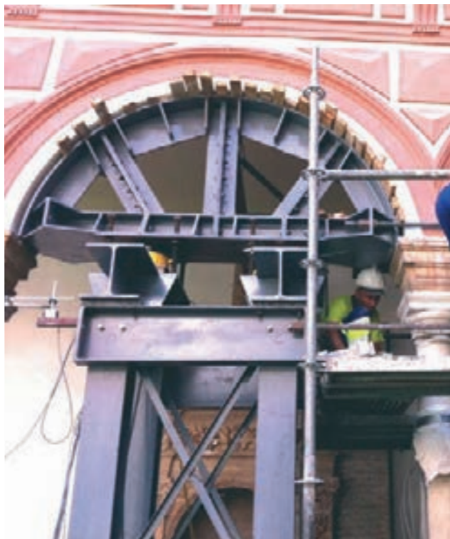
Figura 8. Detalle del doble apoyo con reparto y sobre neumáticos y detalle de las uniones atornilladas de la parte superior. También se aprecia parte de la instrumentación y la falta de acuña en el sector exterior.
