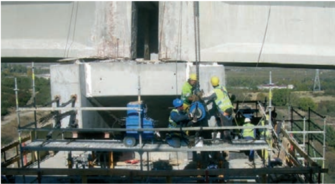
Figura 34. Pretensado de los nuevos dinteles
