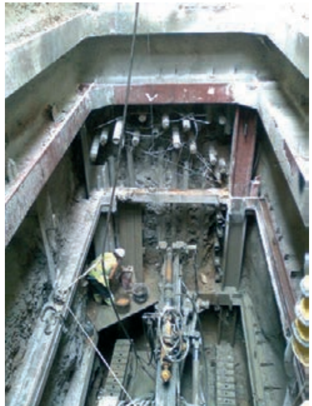
Figura 10. Ejecución del paraguas de micropilotes
