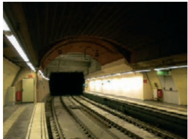
Figura 27. Aspecto de la obra terminada
