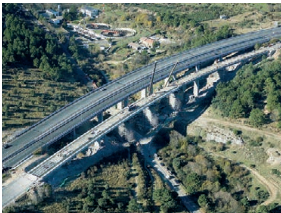
Figura 35. Vista aérea de los trabajos sobre el tablero
