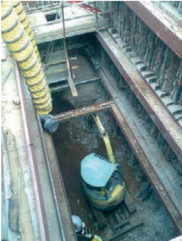
Figura 8. Excavación del pozo de ataque
