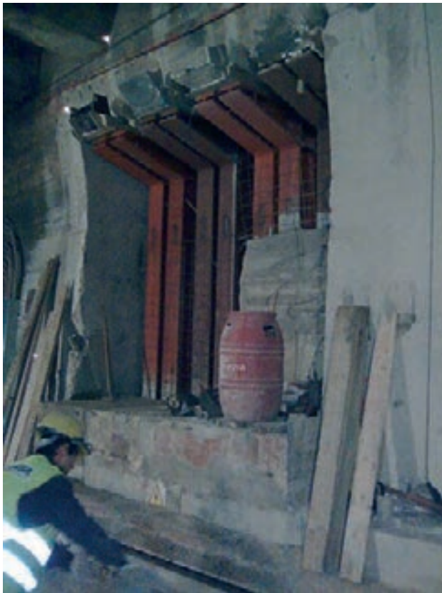
Figura 19. Hormigonado del hastial
