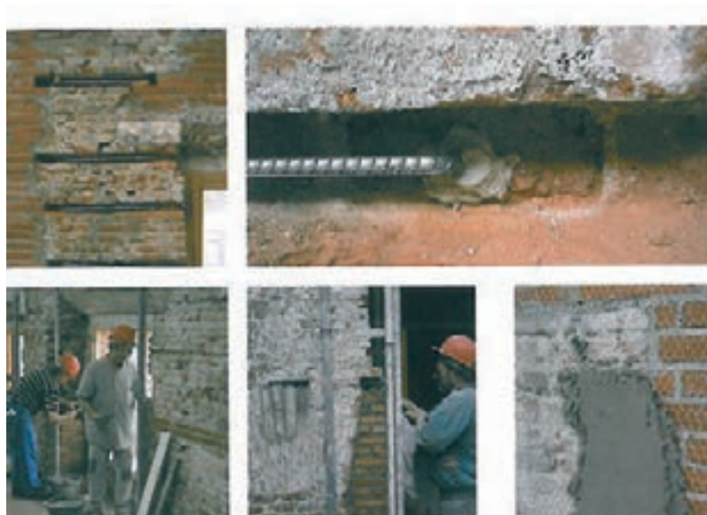
Figura 4. Consolidación de muros
