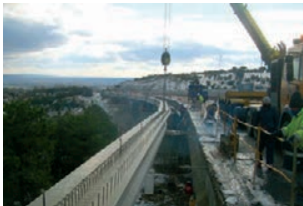
Figura 40. Colocación de vigas nuevas
