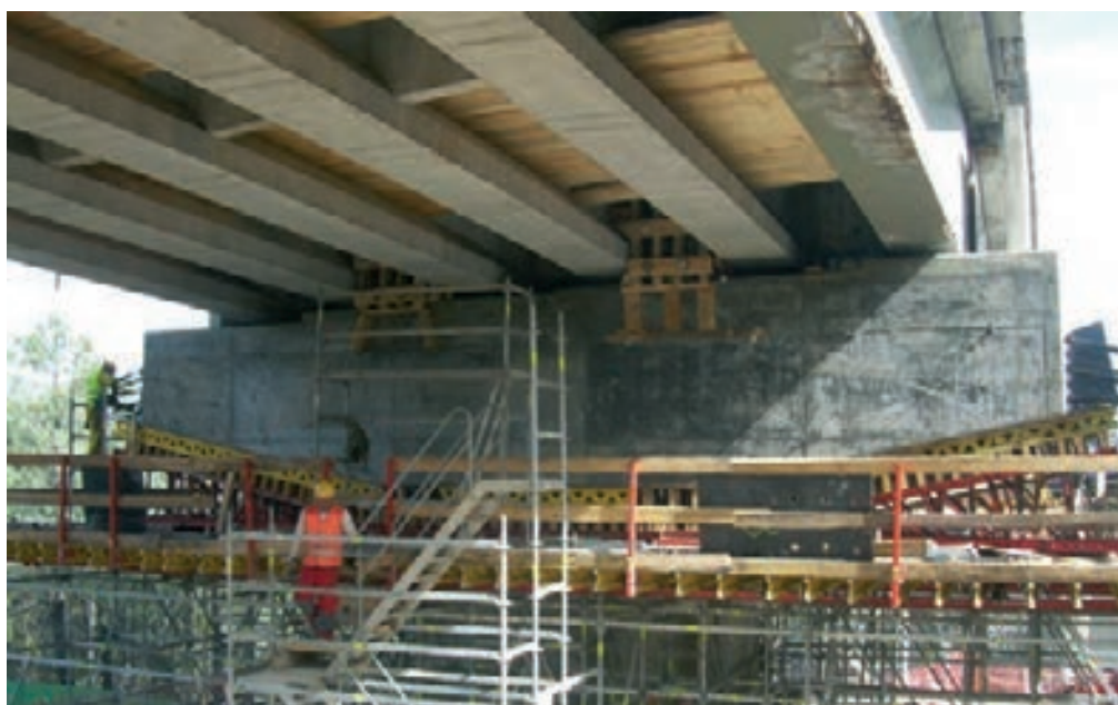
Figura 33. Hormigonado de dinteles y vigas de cuelgue
