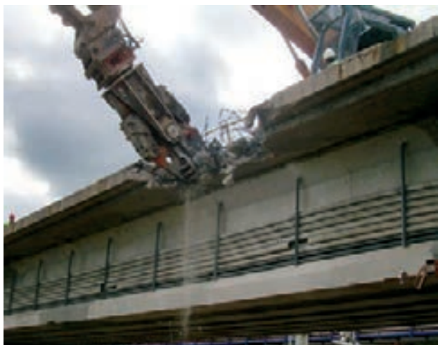
Figura 36. Demolición de losa existente: aceras y voladizos
