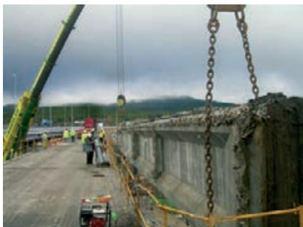
Figura 39. Retirada de vigas dañadas
