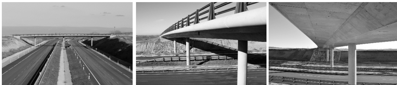
Figura 1. Puente integral monitorizado con tablero de hormigón postesado situado en la Provincia de Ávila, España
