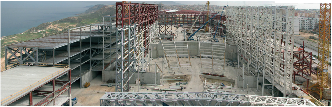
Figura 13. Vista de la caja central del auditorio durante la construcción
