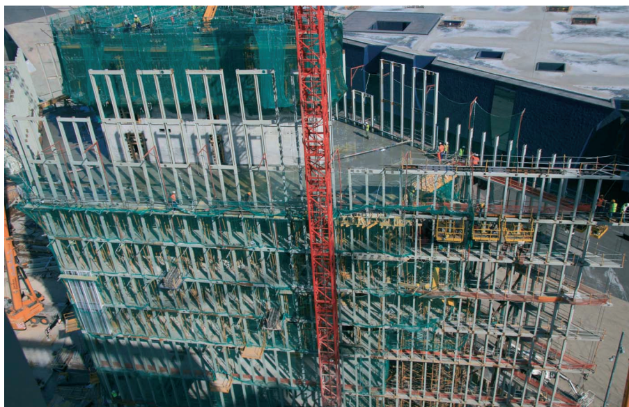
Figura 29. Construcción de la capa interior de fachada mediante módulos (vista desde el Hotel Diagonal ZeroZero) Figure 29. Facade inner layer under construction through columns sets (view from the Hotel Diagonal ZeroZero)
