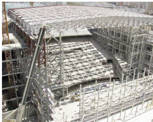
Figura 37. Vista de la cubierta prácticamente concluida
