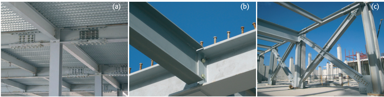
Figura 10. Detalle de uniones atornilladas en vigas principales (a), articulación de una correa en su extremo (b) y uniones atornilladas de arriostramientos sísmicos (c)
