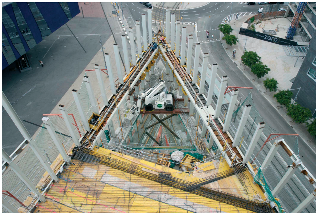
Figura 17. Patio inferior durante la construcción (vista desde el núcleo)
