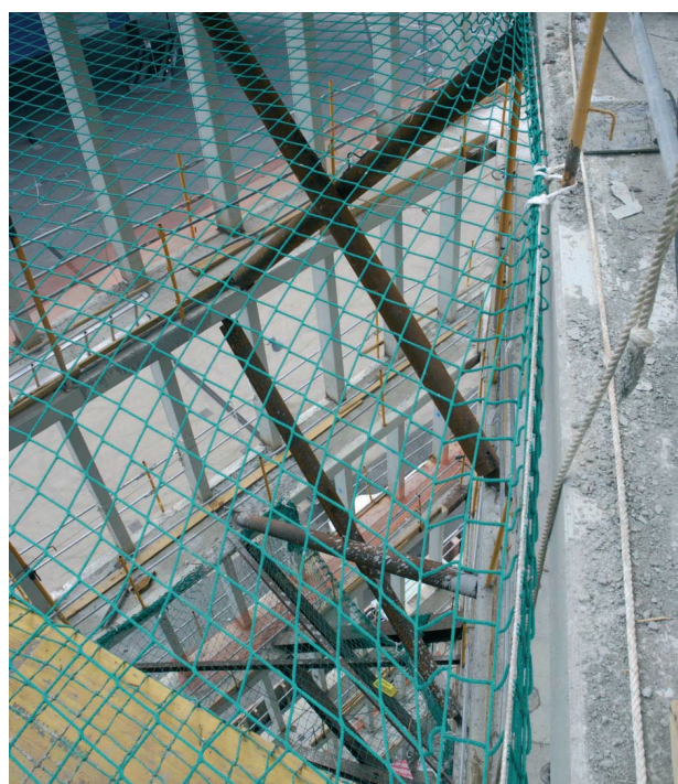
Figura 30. Arriostramiento provisional capa interior fachada en patio
