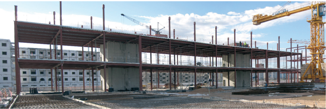
Figura 7. Vista del edificio de entrada apeado durante la ejecución. Forjados de niveles 1 y 2 ejecutados
