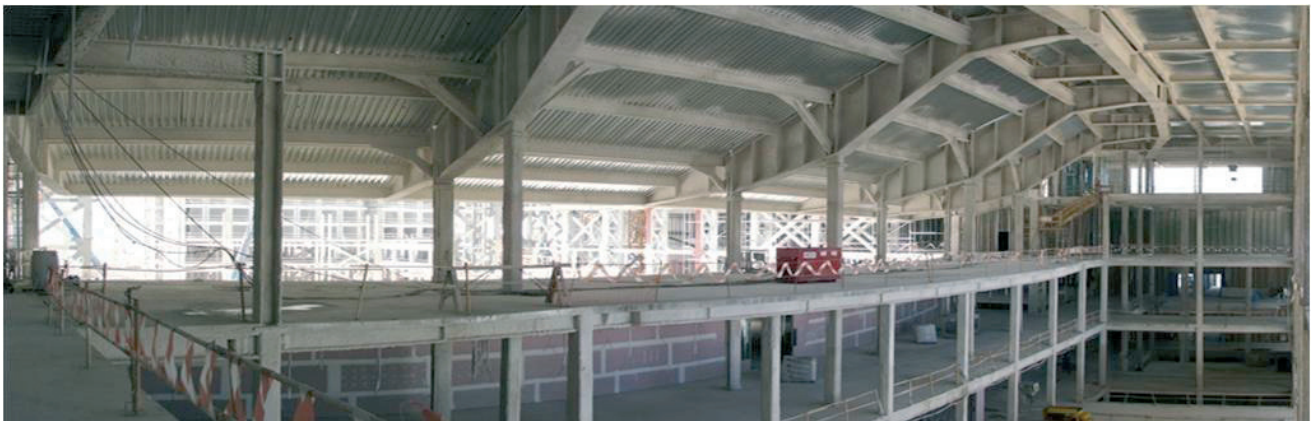
Figura 35. Vista trasera de las vigas principales del graderío superior
