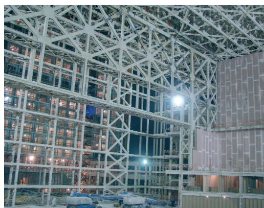
Figura 16. Vista del pórtico de arriostramiento del eje 26 sobre el escenario del auditorio
