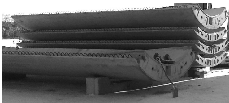
Figura 12. Segmentos de la torre de Hamina a la espera de su colocación definitiva
