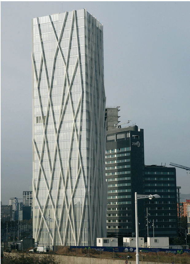
Figura 36. Edificio terminado. Vista desde las áreas del Fórum Figure 36. Finished building. View from the Forum areas
