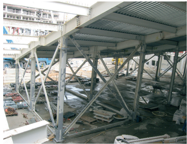
Figura 34. Vista de los arriostramientos durante la ejecución
