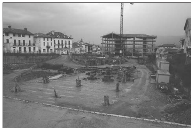
Figura 20. Edificio 1 en ejecución (Octubre 2009), al lado del Pont-Neuf (Av. Charles de Gaulle), y aspecto de la losa terminada, vista desde el nuevo Pont-Vieux, con la armadura de pilares del resto de edificios en espera para ejecución
