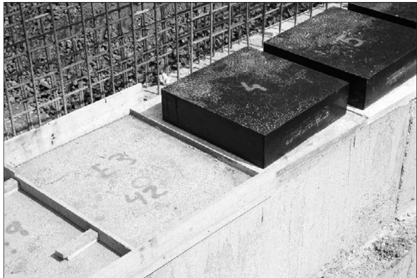
Figura 14. Aparatos de apoyo de neopreno zunchado
