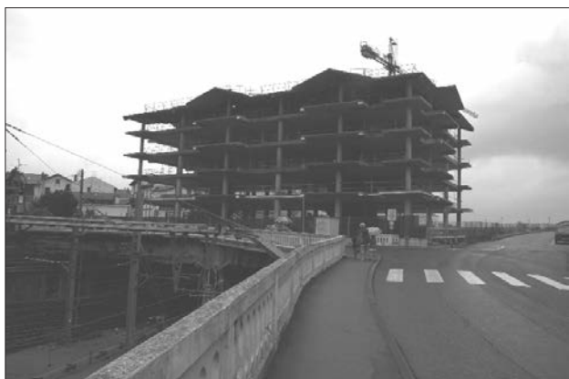
Figura 20. Edificio 1 en ejecución (Octubre 2009), al lado del Pont-Neuf (Av. Charles de Gaulle), y aspecto de la losa terminada, vista desde el nuevo Pont-Vieux, con la armadura de pilares del resto de edificios en espera para ejecución
