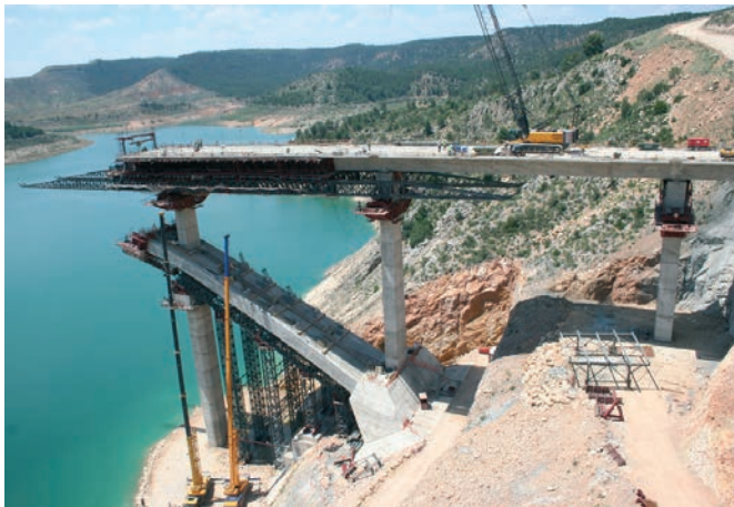
Primer tramo de arco apeado First stretch of the temporarily supported arch
