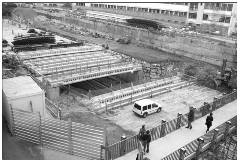
Figura 17. Aspecto de la trinchera tras demoler el Pont-Vieux e instalar una pasarela peatonal provisional
