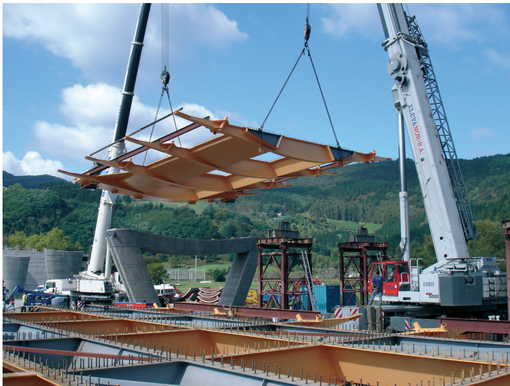
Figura 27. Secuencia de montaje de un tramo del tablero metálico Figura 27. Erection sequence of a steel deck segment
