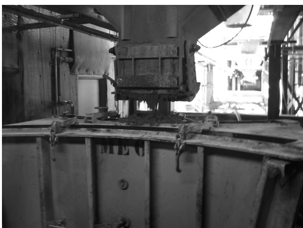
Figura 5. Detalle del hormigonado con molde vertical
