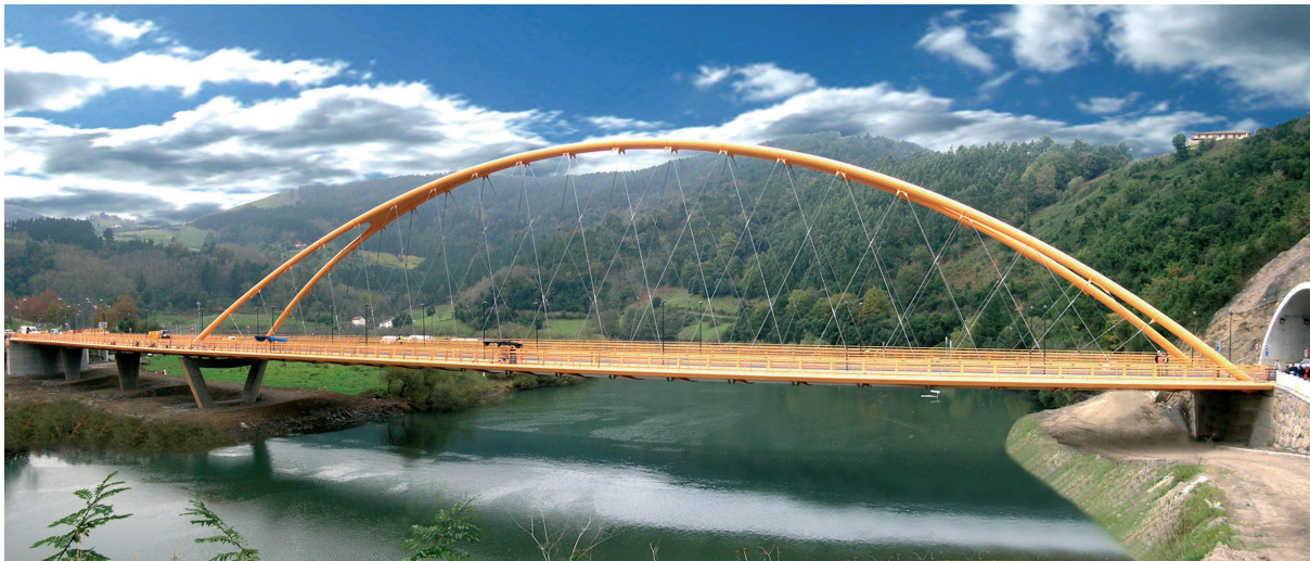
Figura 11. Vista desde aguas abajo Figure 11. Downstream view
