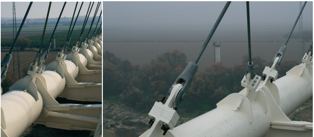
Figuras 33a y 33b. Detalles de anclajes de péndolas inferiores y arranques de vigas transversales dispuestas cada 5 m en el tablero Figures 33a and 33b. Details of hanger anchorage and transverse girders ends at 5 m intervals along the bridge
