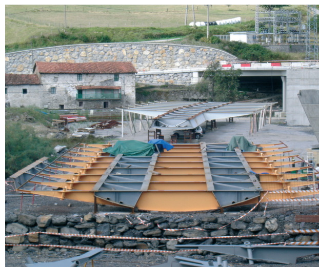
Figura 16. Vista del tablero del puente arco, en primer término, y del tablero del viaducto de acceso al fondo, previa a su colocación
