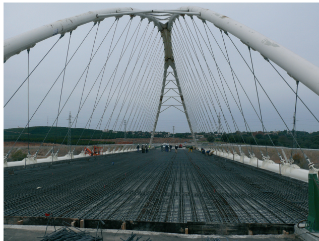
Figuras 42a y 42b. Vista durante las operaciones de colocación de prelosas en el tablero y con el tablero ferrallado Figures 42a and 42b. Views of the precast slabs placing and of the deck after the reinforcement being assembled
