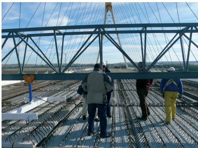
Figuras 42a y 42b. Vista durante las operaciones de colocación de prelosas en el tablero y con el tablero ferrallado Figures 42a and 42b. Views of the precast slabs placing and of the deck after the reinforcement being assembled
