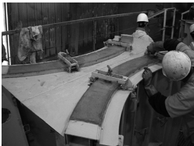
Figura 6. Detalle del acabado superficial superior
