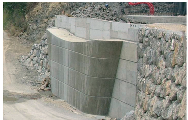
Figura 26. Estribo 2 del lado del puente arco antes del túnel Figure 26. Arch bridge abutment 2 before the tunnel
