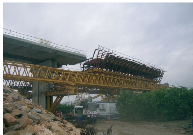
Figuras 30a y 30b. Sección transversal de la losa ampliada y vista durante la ejecución con autocimbra Figures 30a y 30b. Slab cross-section after widening and view of erection with falsework
