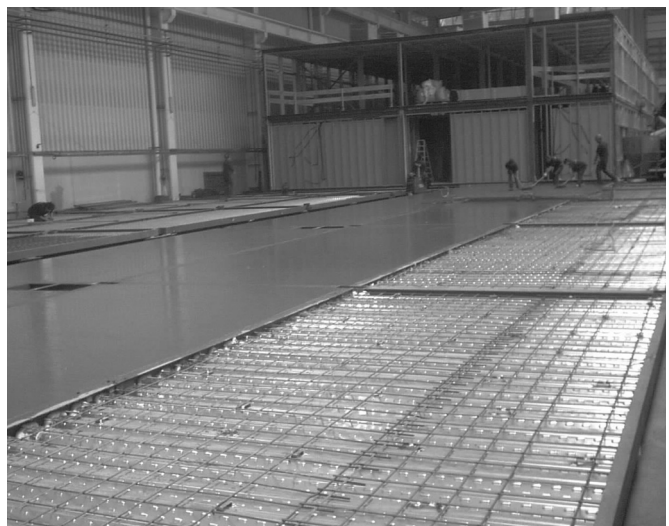
Figura 28. Factoría MODULTEC (Asturias). Interior de la nave con el hormigonado de las placas base de chapa colaborante.
