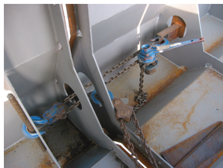
Figura 44. Utilización de los rigidizadores como auxiliares en el ensamblaje de cajones. Figure 44. Use of the stiffeners as auxiliary elements for the erection of caissons.
