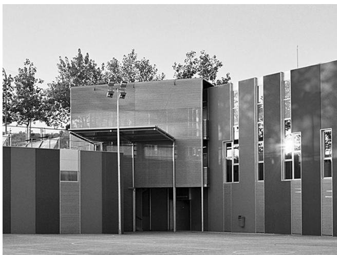
Figura 4. C.E.I.P. Ponent (Terrassa). Prefabricado de hormigón armado y pretensado. Arquitectura: F.Pich-Aguilera arq. Estructura: Prefabricados Pujol.
