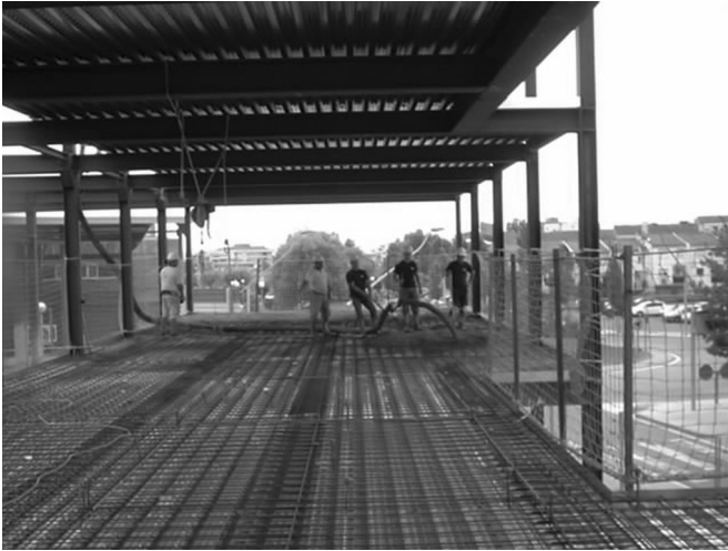
Figura 46. Hormigonado del forjado colaborante, conectado a los pórticos transversales mediante tornillos autoroscantes.
