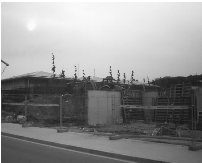
Figuras 38 y 39. Muros de contención recalce de la cimentación de la primera fase de Infantil (caracolas con cubiertas piramidales) del CEIP, para construir el edificio contiguo de Primaria.
