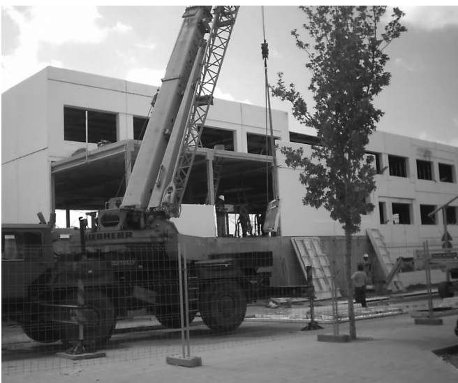
Figura 47. Montaje de los cerramientos ligeros de GRC (Microhormigón reforzado con fibras de vidrio).
