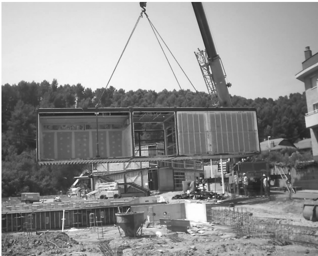
Figura 33. Una grúa móvil transporta un módulo desde el camión llegado de Asturias hasta su ubicación sobre los pilarcitos.
