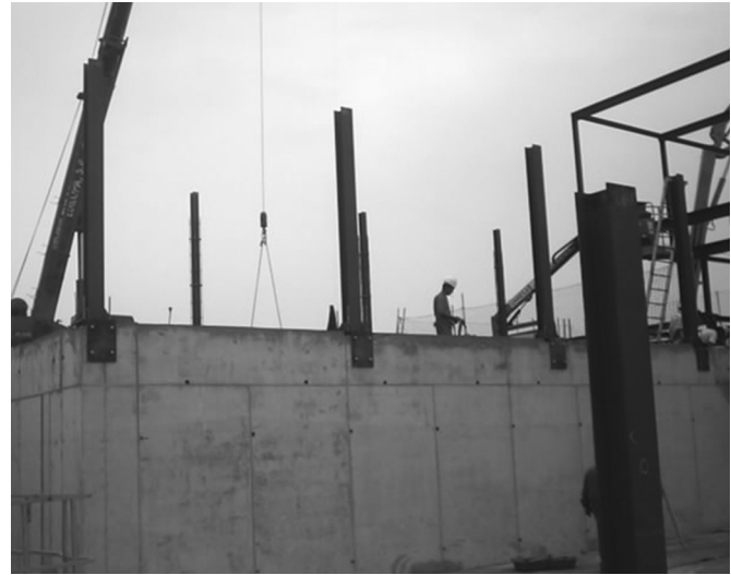
Figura 41. Placas metálicas conectadas con anclajes mecánicos atornillados al muro cambio de nivel, a la espera de los pórticos transversales.
