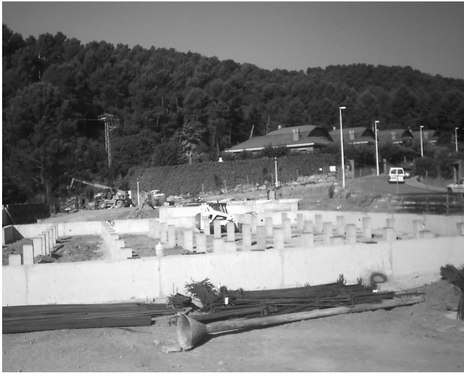
Figura 31. Pilares enanos del sanitario coronados por placas metálicas, a la espera de la llegada de los módulos integrales.
