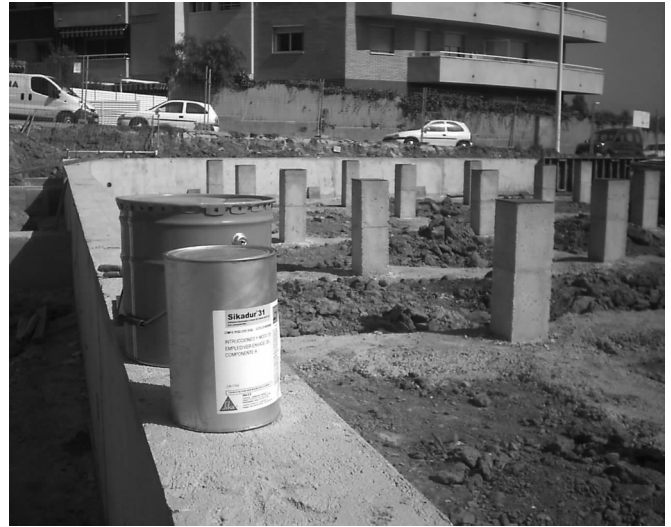
Figura 32. Detalle de los pilarcitos con la placa de apoyo pegada con resina epoxi SIKA 31.
