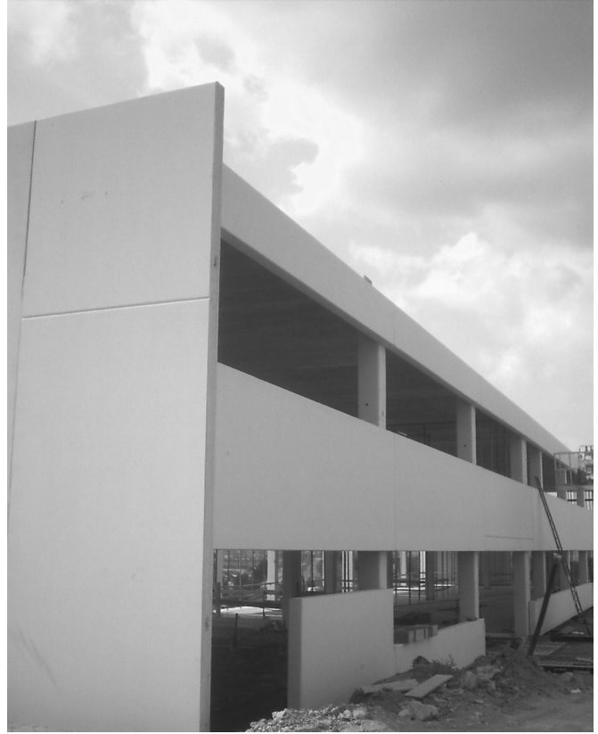
Figura 14. Fachada de entrada al C.E.I.P. con los cerramientos colgados de la estructura y testero de placas prefabricadas
