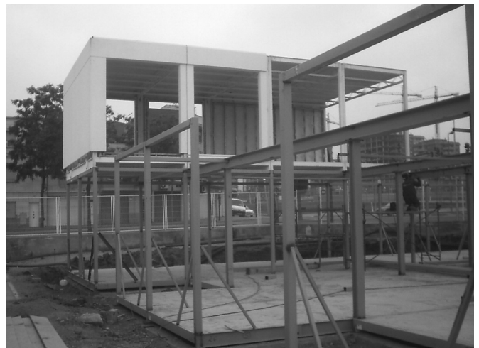
Figura 18. Los módulos prefabricados en la factoría DRACE de Sevilla son una caja con dimensiones múltiples de 2,70 m. en planta y altura libre de 2,88 m.
