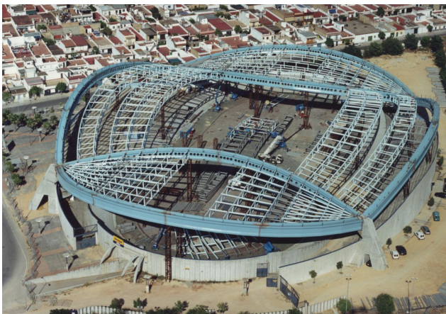
Figura 57. Montaje de la malla. Figure 57. Erection of the mesh.
