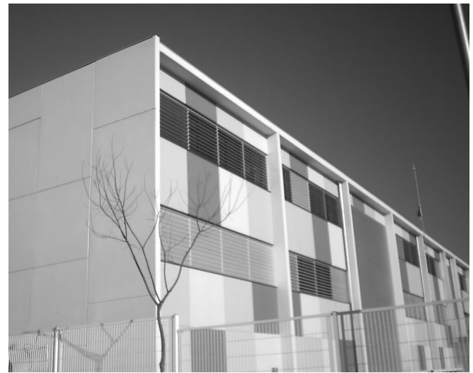
Figura 16. Fachada del edificio prefabricado de pórticos de hormigón armado, con pilares, jácenas y placas alveolares y también cerramientos prefabricados, en la última fase de construcción de la escuela de colocación de los marcos apaisados de las ventanas de las aulas y pintado exterior por damas.
