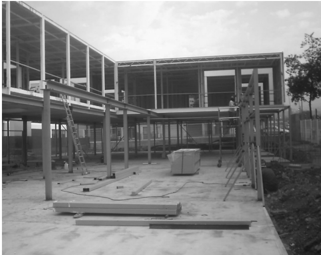
Figura 19. Montaje de los módulos encima la estructura de apeo de planta baja, para conseguir espacios diáfanos en vestíbulo y comedor.
