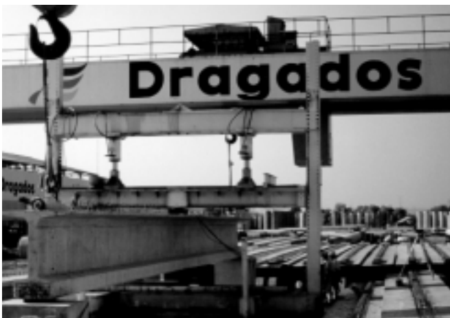
Figuras 9 y 10: Pasarela del Puerto de Málaga y prueba de carga de la viga de ensayo.
