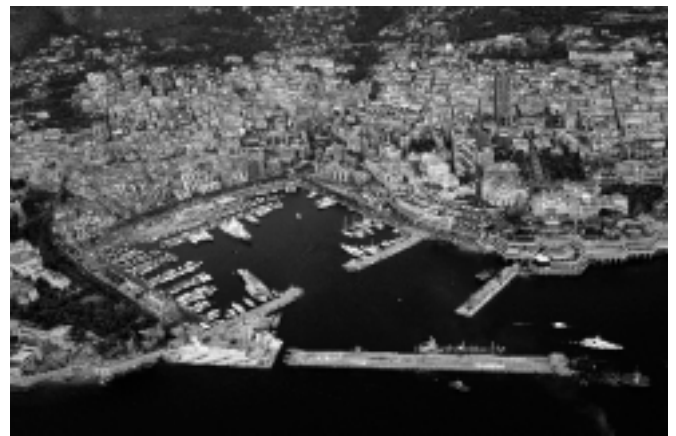
Figuras 17 y 18: Fabricación del dique en Algeciras e instalación en Mónaco.
