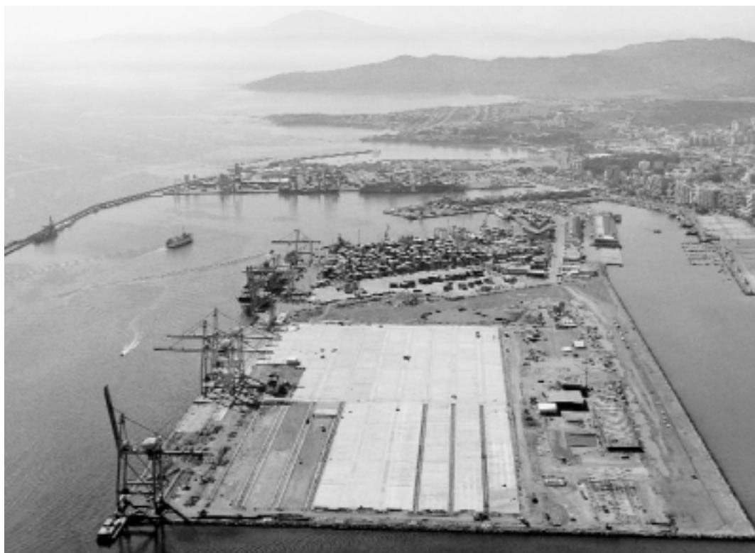
Foto 4. Pavimento Puerto de Algeciras.
