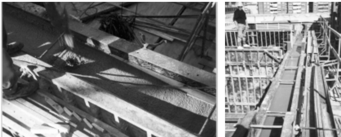
Foto 6. Fase final de la aplicación del HAC.
