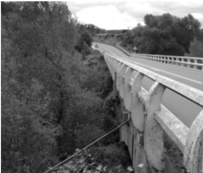
Figura 3. Entrada al puente de Sacal.
