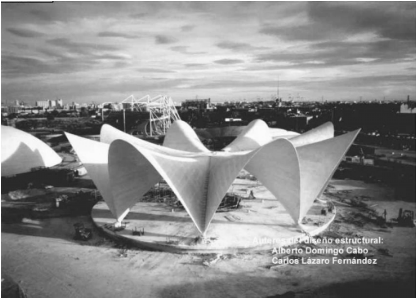
Foto 26. Ejecución Bóveda Restaurante Parque Oceanográfico.
