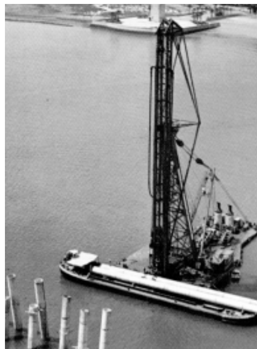
Figuras 5 y 6: Factoría de prefabricados y cabria de hinca de pilotes en Huelva.
