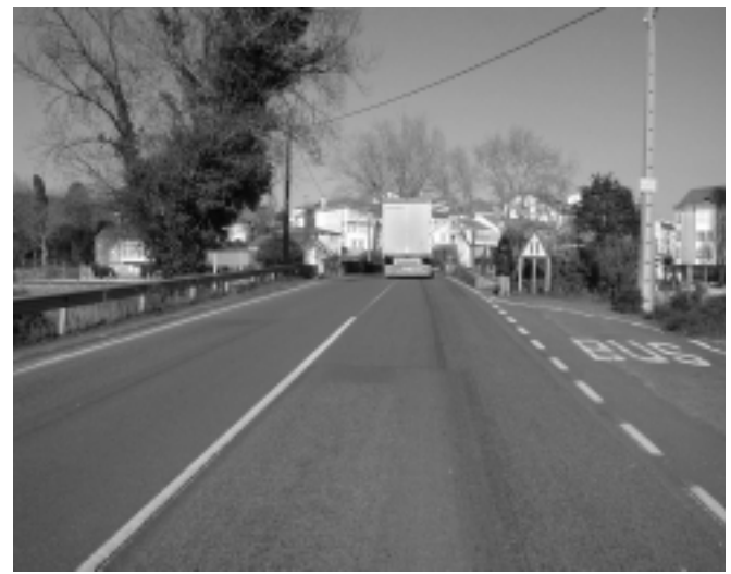
Figura 4. Entrada al puente de Ponteceso.
