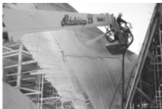
Figura 12. Hormigonado por calles de los lóbulos.
