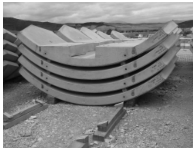
Foto 16. Canal de Navarra. Apilado de dovelas.
