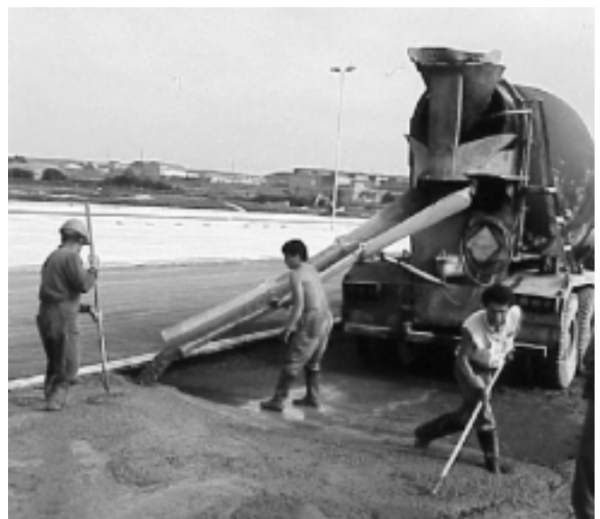
Figura 3. Puesta en obra de un hormigón con fibras de acero.
