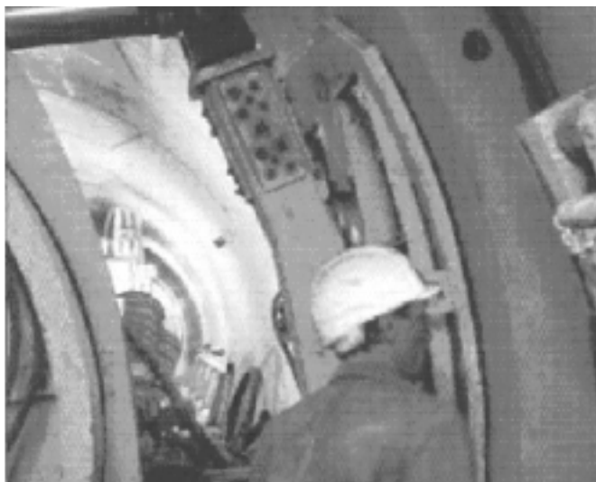
Foto 17. Túnel de Sorenberg. Colocación dovelas.
