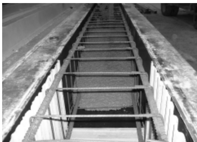
Fig. 10. Puesta en molde de pilares del HAC.
