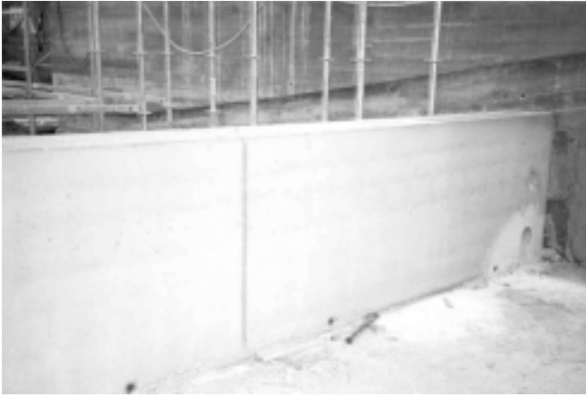
Foto 4. Estructura hormigonada durante la fase de pruebas previas.
