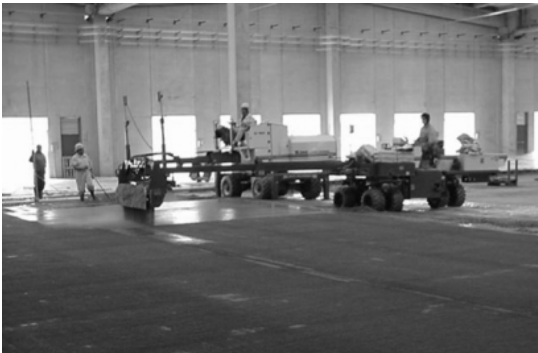
Foto 3. Pavimento sin juntas.
