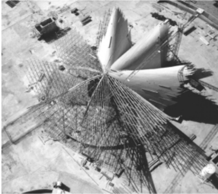
Figura 5. Vigas y tablas del encofrado.
