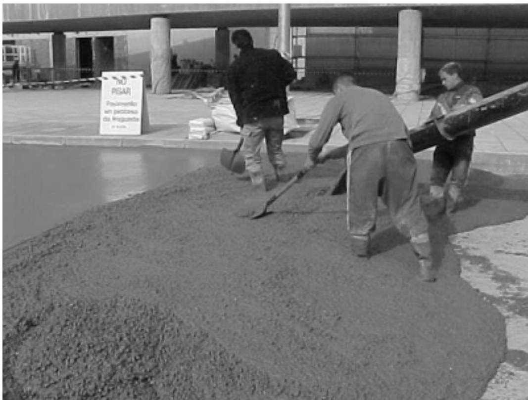
Foto1. Pavimento Tradicional armado con fibras de acero.
