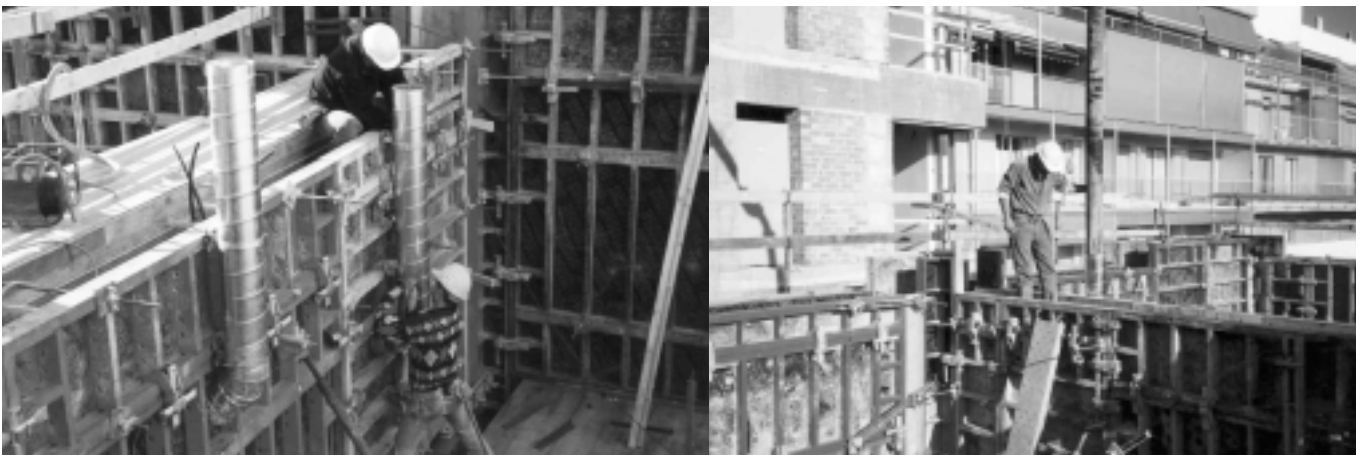
Foto 5. Detalle del montaje de los tubos y fase inicial del hormigonado.
