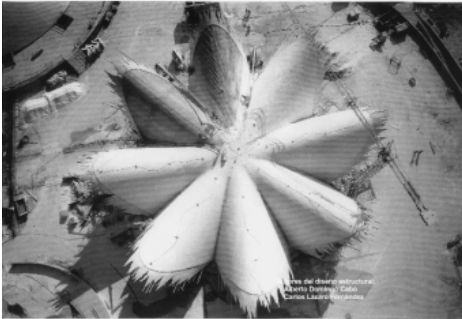
Foto 25. Ejecución Bóveda Restaurante Parque Oceanográfico.
