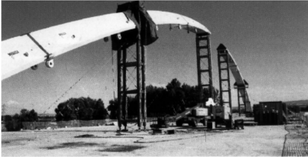
Foto 8. Arco atirantado del Puente del Barrio de las Fuentes.
