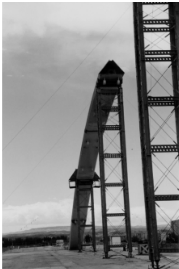
Foto 11. Detalle de la sección del arco a hormigonar.
