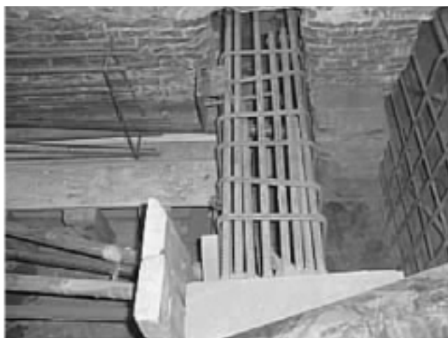
Foto 12. Estructuras a hormigonar.
