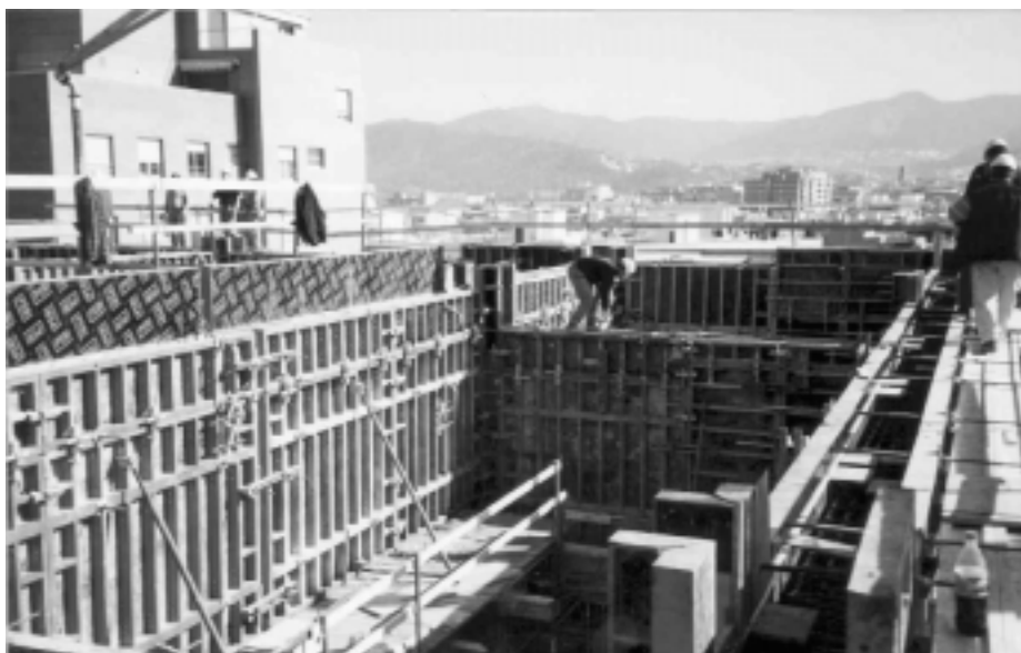
Foto 1. Vista de la distribución de muros a hormigonar.
