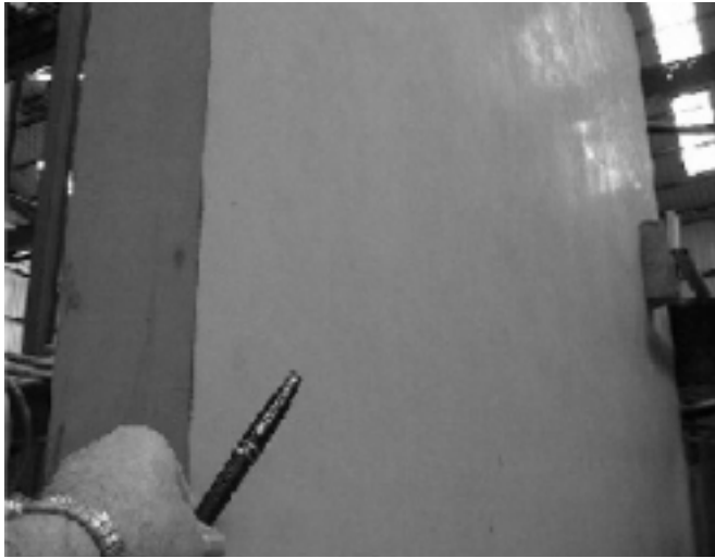
Foto 22. Acabados en la prefabricación de paneles con HAC.
