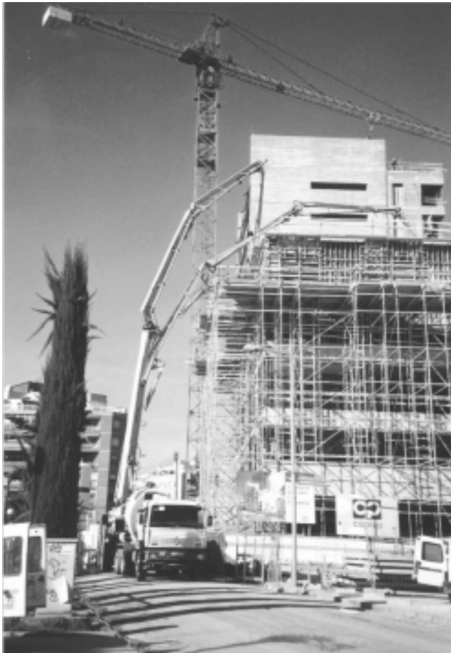
Foto 2. Vista general de la obra.
