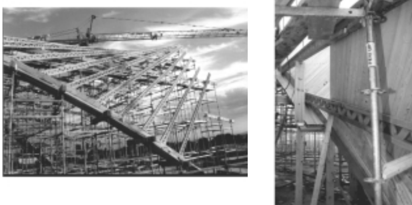
Figura 4. Vigas principales y encofrado de madera.
