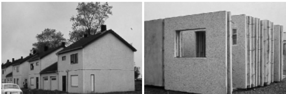
Figura 5. Viviendas prefabricadas con hormigón con fibras de acero en Bélgica.
