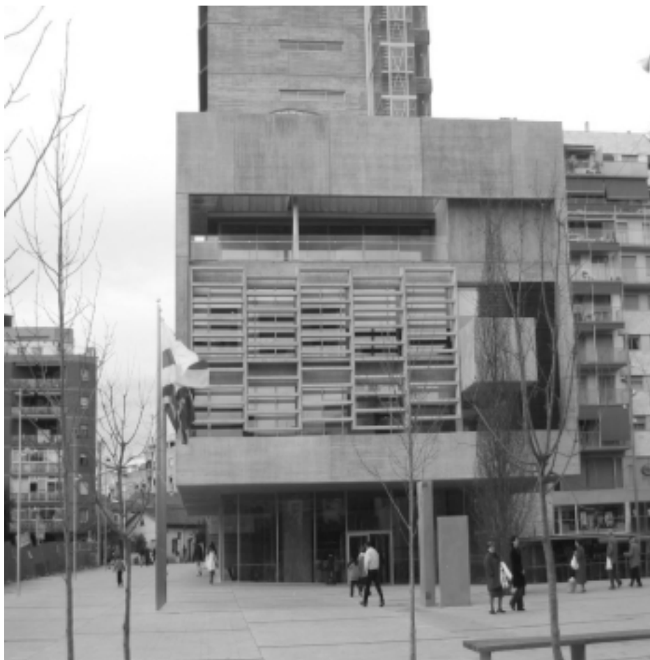
Foto 7. Vista del nuevo edificio del Ayuntamiento de Mollet del Vallès prácticamente concluido, donde se observa el muro de la cuarta planta realizado con HAC.
