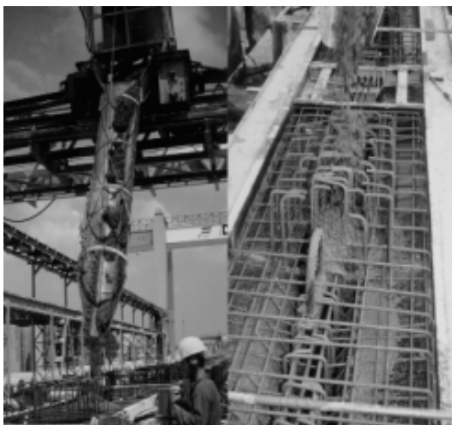
Figuras 1 y 2: Fabricación y acopio de vigas de HAR para el Puente del Guadalete.
