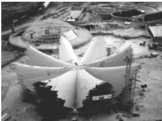
Figura 7. Encofrado de la cubierta JChypar.
