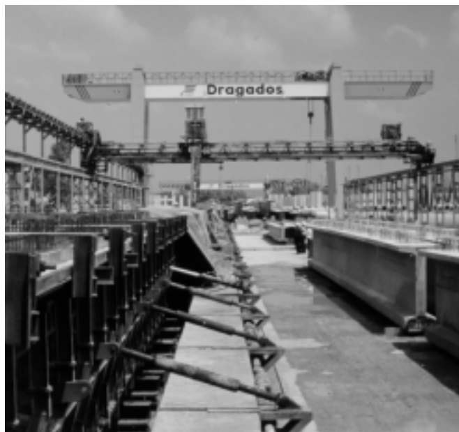
Figuras 1 y 2: Fabricación y acopio de vigas de HAR para el Puente del Guadalete.
