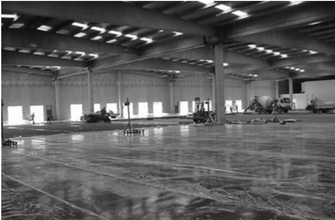
Foto 2. Pavimento sin juntas.
