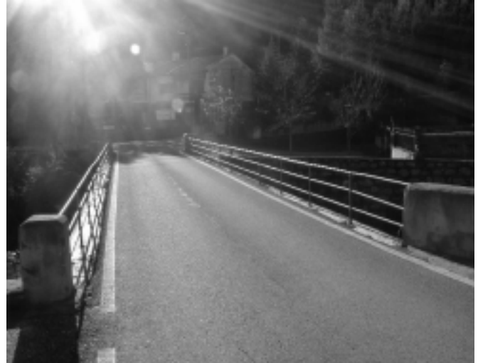
Figura 2. Entrada al puente de Bugía.
