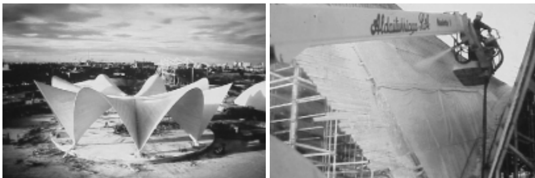
Figura 4. Hiperboloide de ocho hojas (Tesis doctoral A. Domingo Cabo, U.P.V.).
