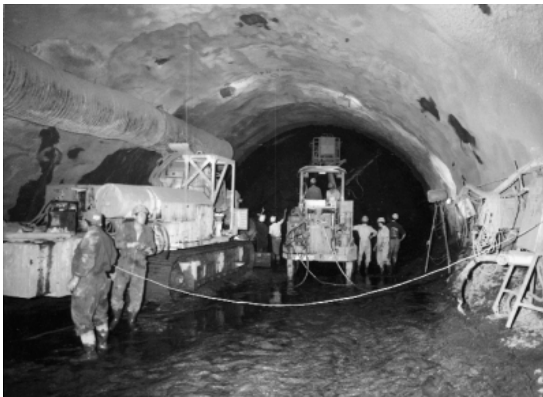
Foto 7. Túnel Metro de Bilbao - Línea 1: Casco Viejo - Bolueta.
