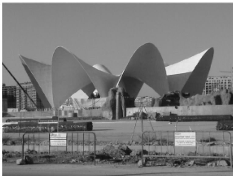
Figura 16. Vista general de la Cubierta JChypar.
