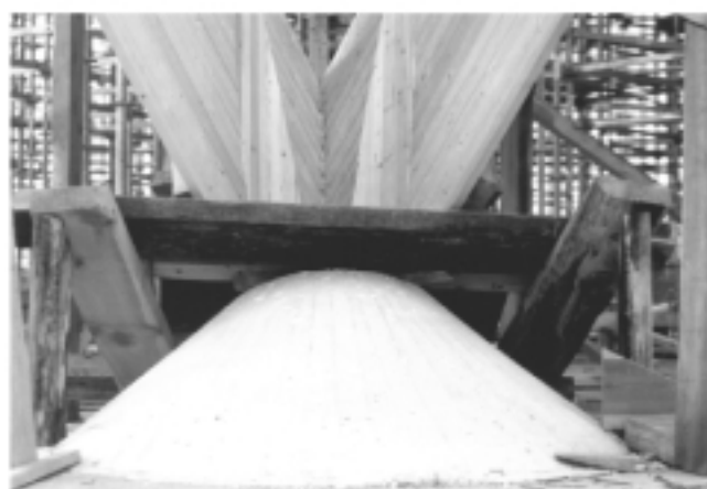
Figura 10. Detalle del apoyo de la lámina.
