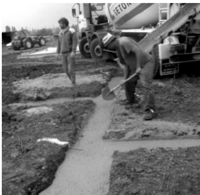
Foto 22. Fundaciones de Viviendas.
