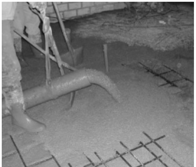
Fogografía 4. Hormigón ligero estructural.
