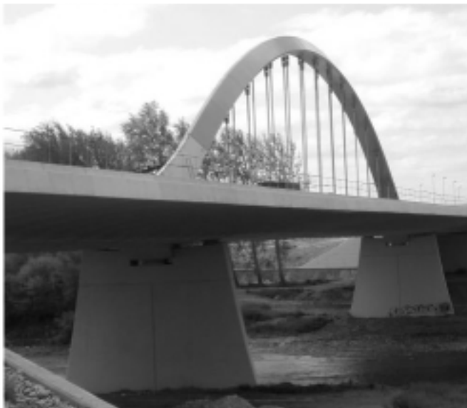
Fogografía 3. Hormigón blanco
