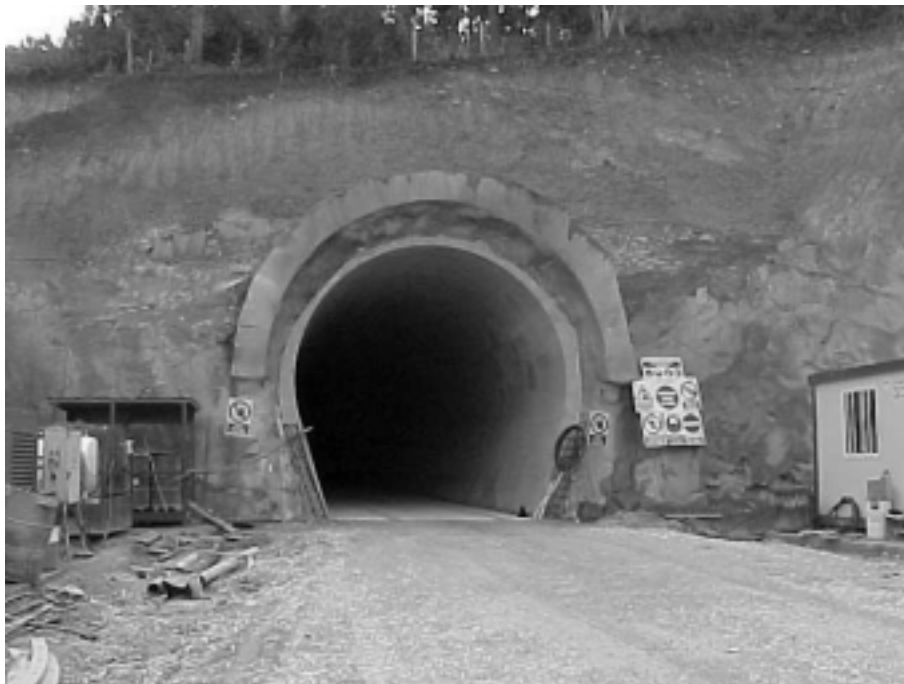
Foto 9. Entrada del Túnel de Gongolaz. Canal de Navarra.
