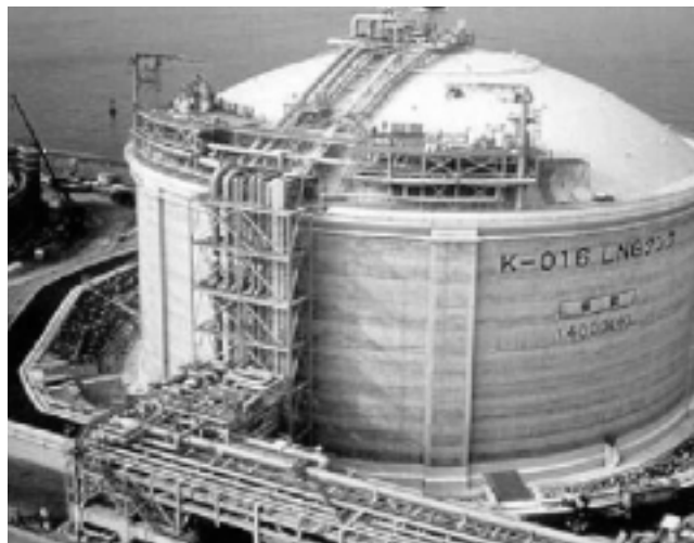
Foto 18. Tanque de gas criogénico de LNG ya operativo.
