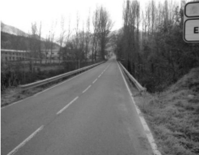
Figura 1. Entrada al puente de Rialbó.
