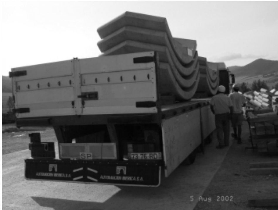
Foto 15. Canal de Navarra. Transporte de dovelas.
