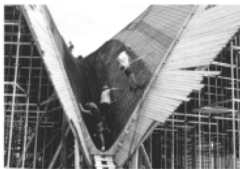
Figura 8. Armado de la lámina.
