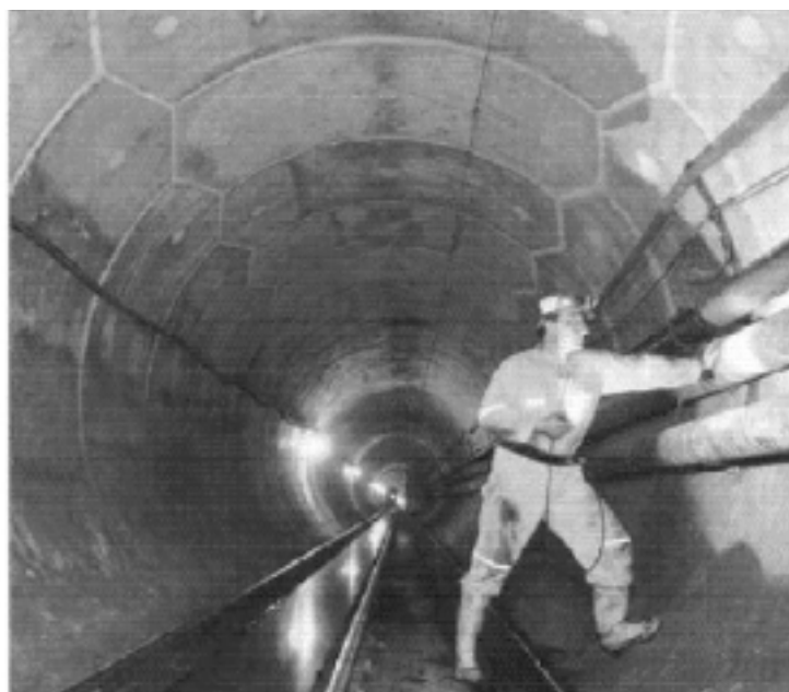
Foto 14. Túnel hidráulico de la Esperanza. Manabí. Vista dovelas.
