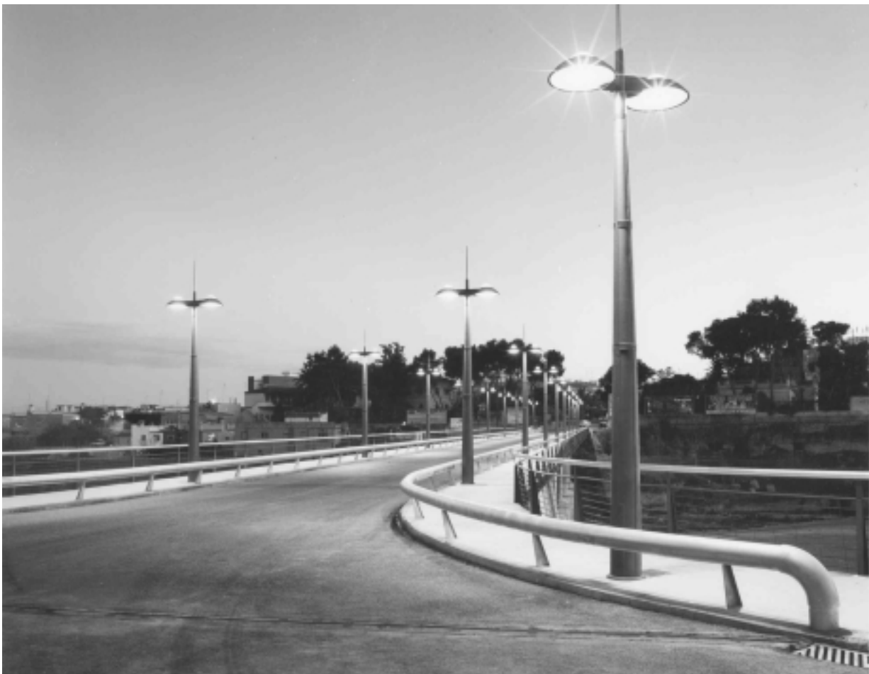
Figura 15. Aspecto final de la ampliación realizada en el puente sobre el barranco del Torrent.
