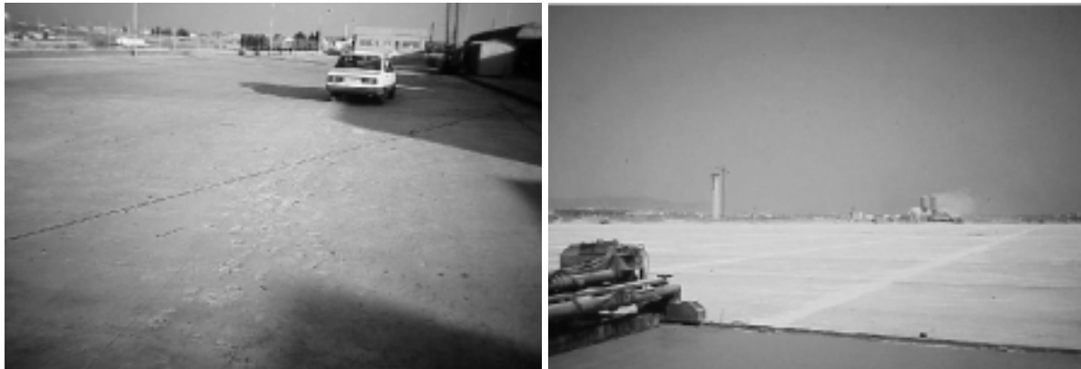
Figura 6. Pavimentos del muelle para contenedores de Mérida y del aeropuerto de Barajas.
