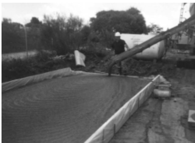
Foto 14. Fase de pruebas para una futura aplicación en un pavimento.
