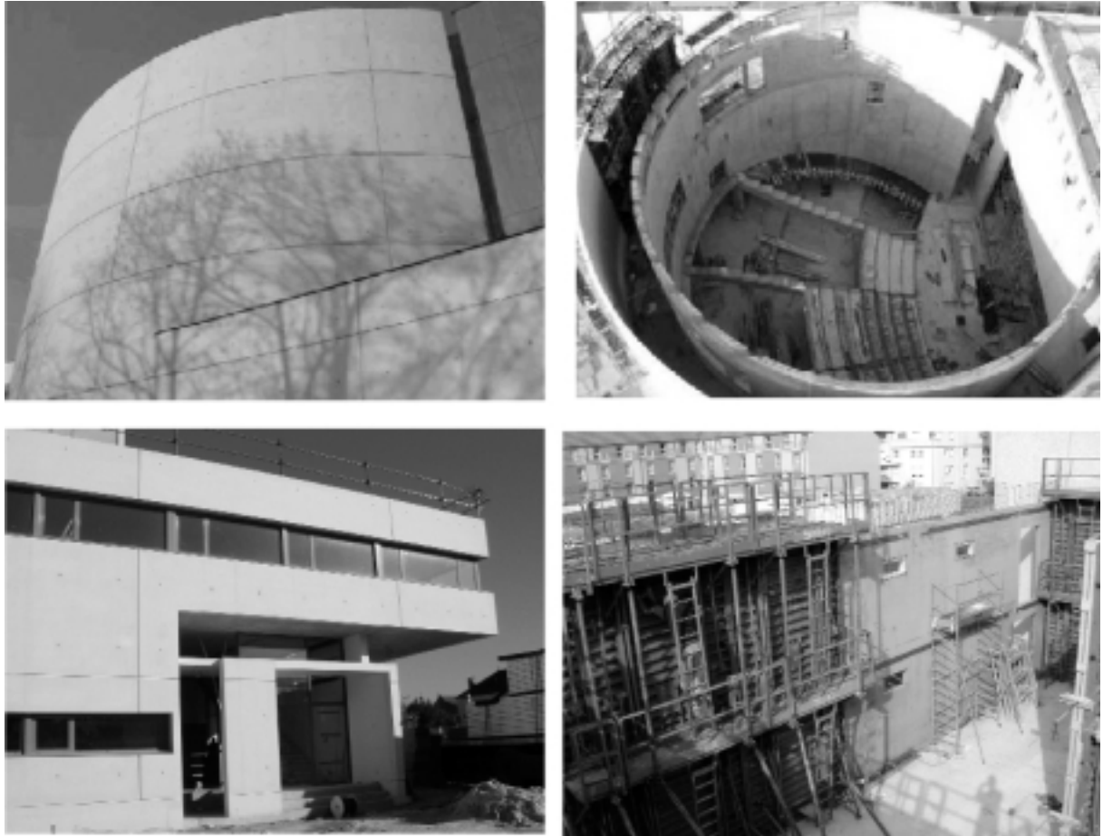
Foto 20. Estructuras cara vista terminadas.
