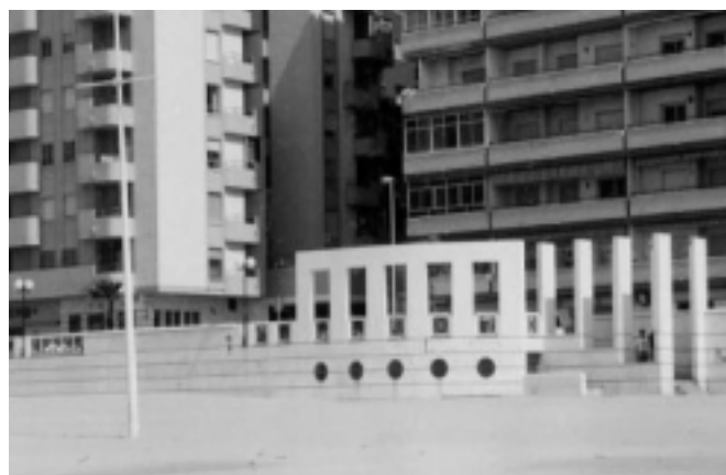
Fogografía 11. Hormigón blanco.
