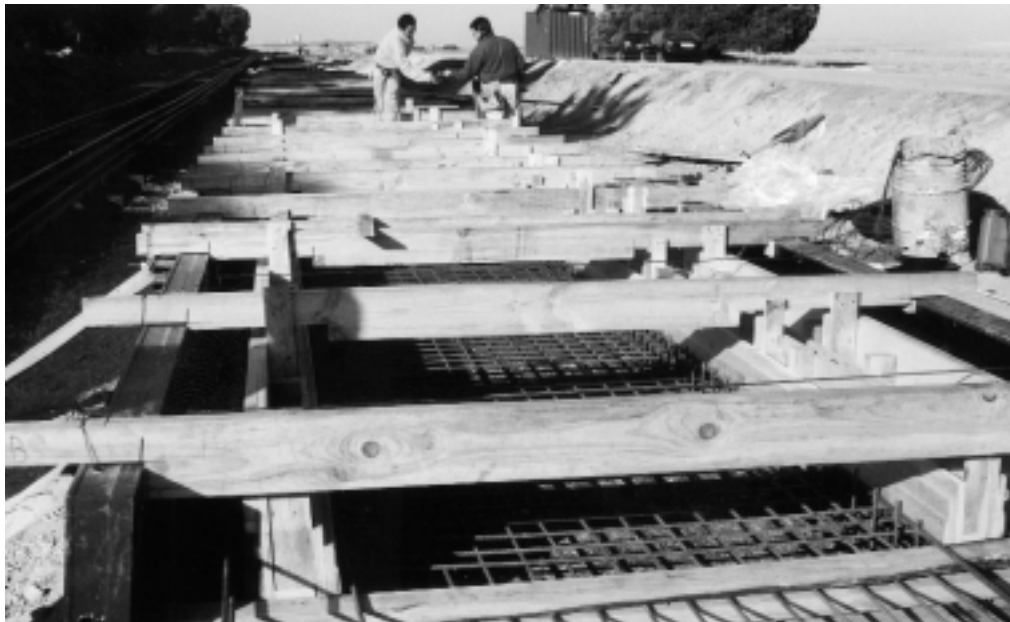
Foto 20. Construcción Viga placa para paso de trenes. Medina del Campo.
