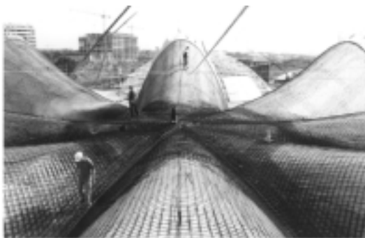
Figura 9. Refuerzos en nervios y clave.
