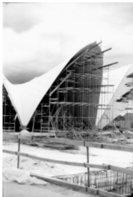
Figura 15. Descimbrado de los lóbulos.
