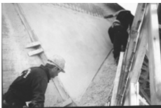
Figura 12. Hormigonado por calles de los lóbulos.
