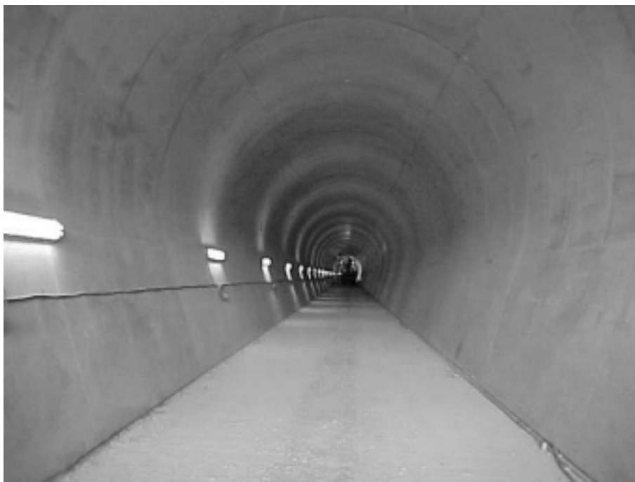
Foto 10. Vista interior Túnel Gongolaz.
