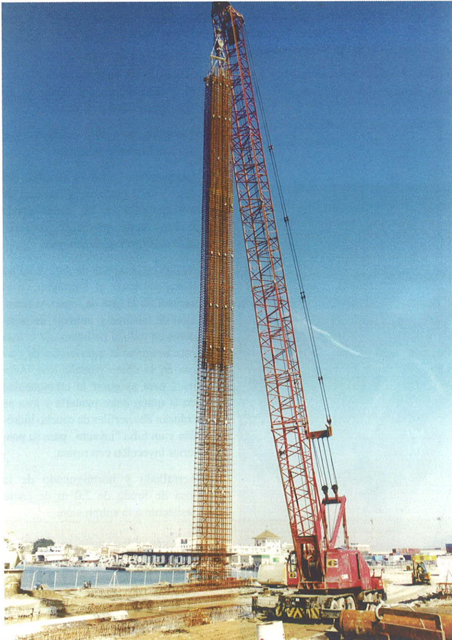
Fig. 18. Jaula de armaduras. Fig. 18. Reinforcement cage.
