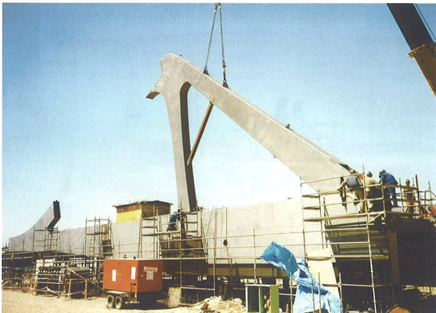
Fig. 23. Montaje en obra. Fig. 23. In-situ erection.
