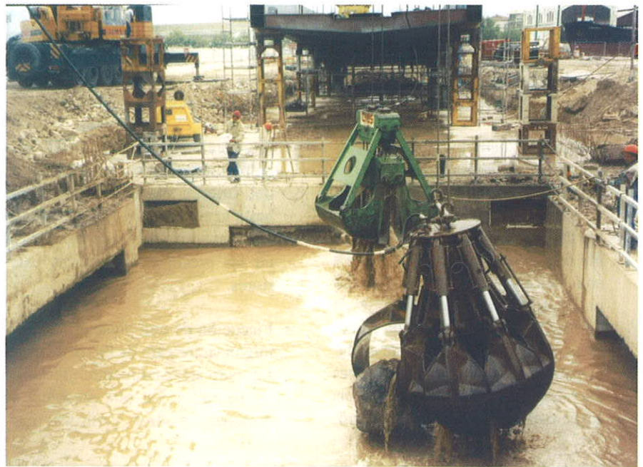
Fig. 19. Excavación interior foso. Fig. 19. Excavation of the inside of the pits.
