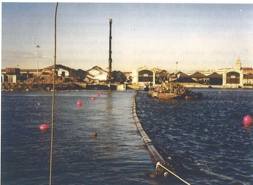
Fig. 17: Tendido tubería submarina. Fig. 17. Laying undersea pipes.
