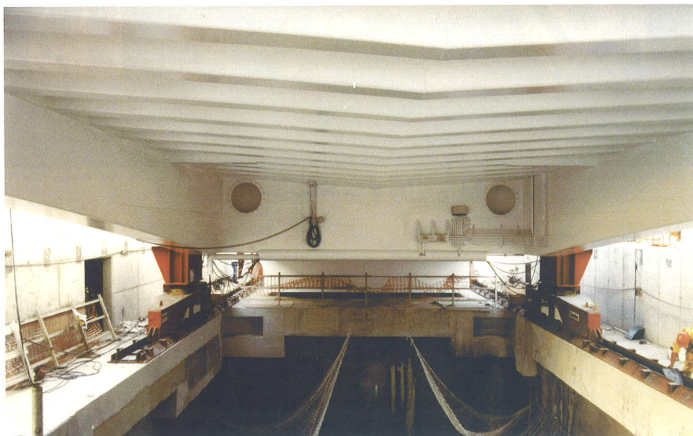
Fig. 25. Lanzamiento. Fig. 25. Launching.
