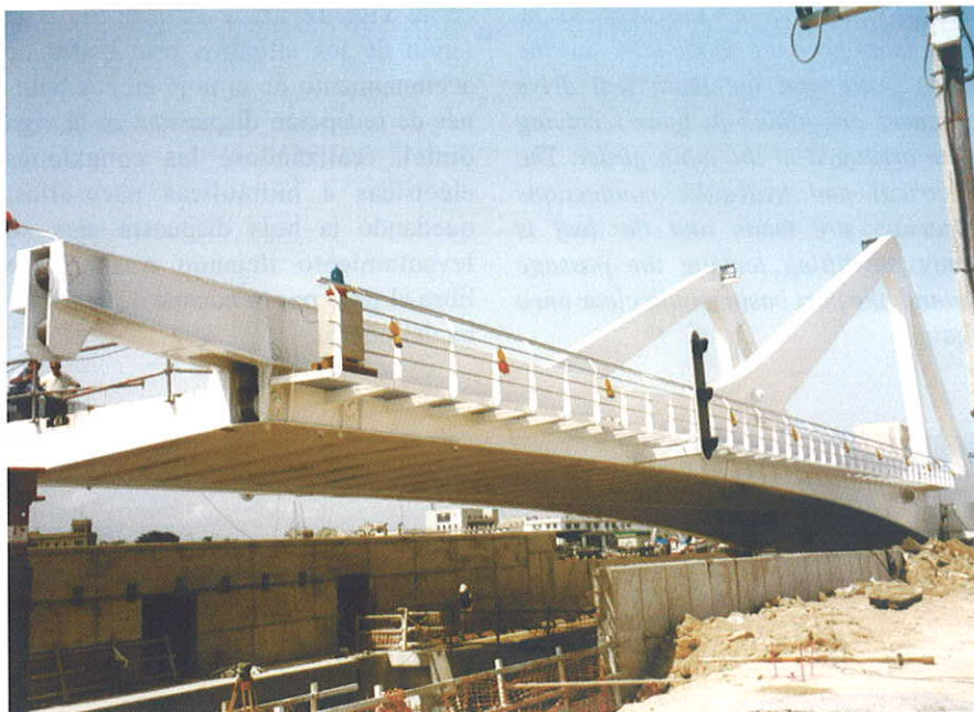
Fig. 24. Lanzamiento. Fig. 24. Launching.
