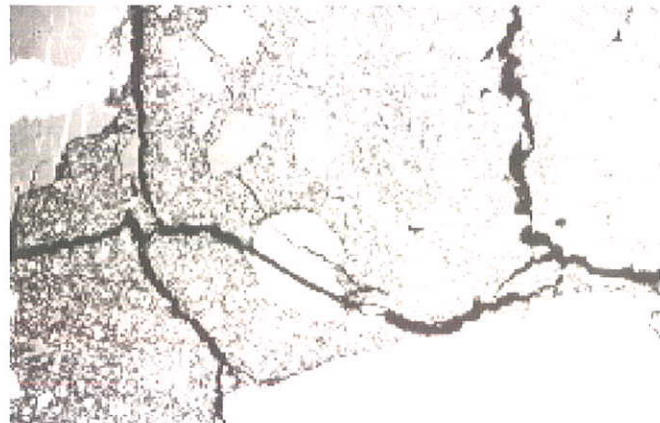
Micrografía 3. Aspecto de un hormigón C 90 tras ser calentado a 500°C. Aparición de microfisuración en pasta y áridos. 50 aumentos.
