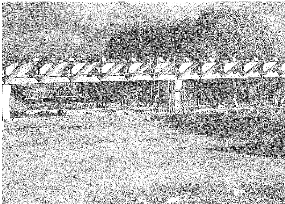
Fig. 5 Puente sobre el río Tormes. Alzado durante la construcción.
