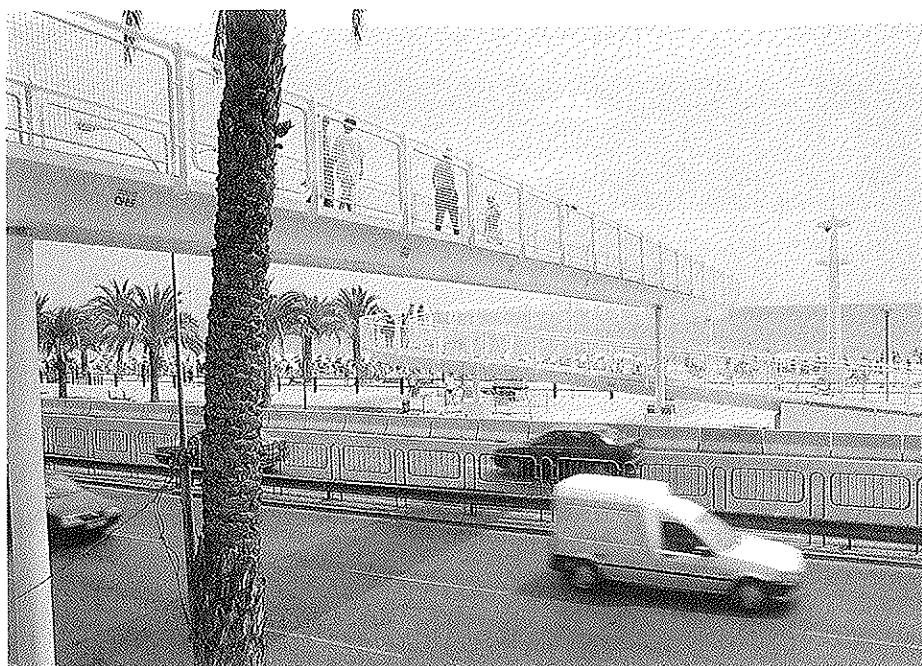
Fig. 3. Vista general de la nueva pasarela.
