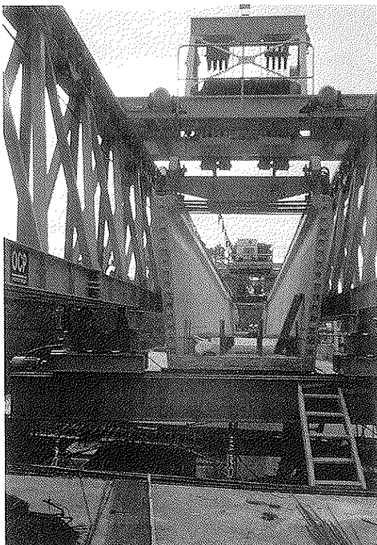
Fig. 8 Puente sobre el río Lambre. Lanzamiento de vigas. Detalle.
