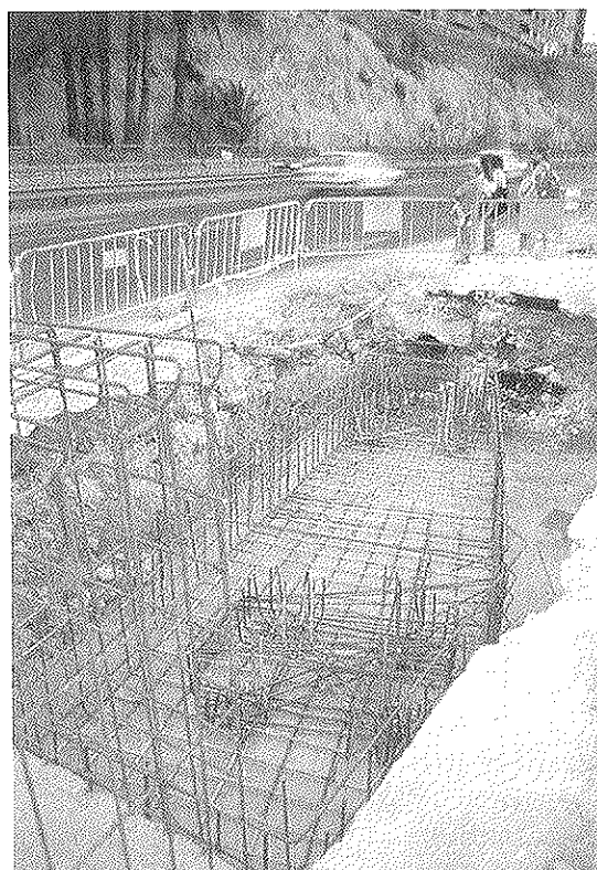
Fig. 4. Encepado conjunto para estribo y soporte.
