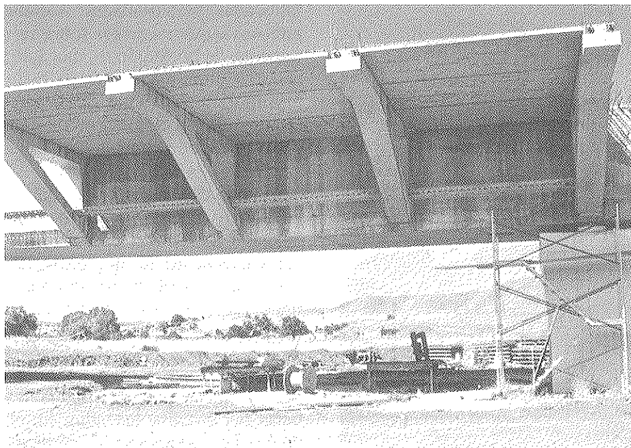
Fig. 6. Puente sobre el río Tormes. Detalle de Jabalcoes prefabricados.
