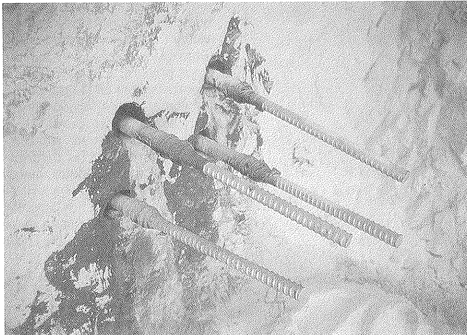
Fig. 11. Ejecución de los anclajes a roca.
