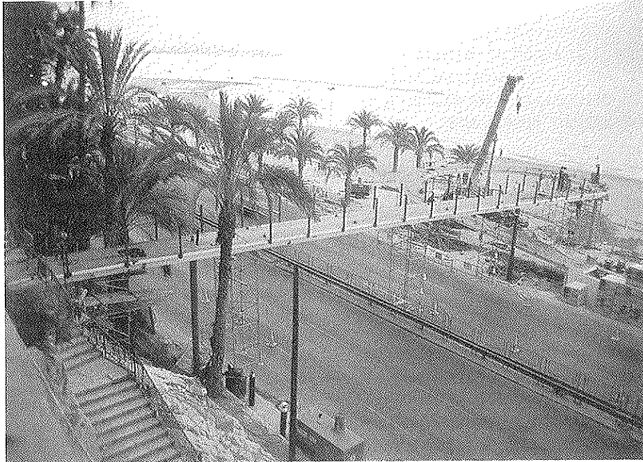
Fig. 13. Vista general del montaje tablero.
