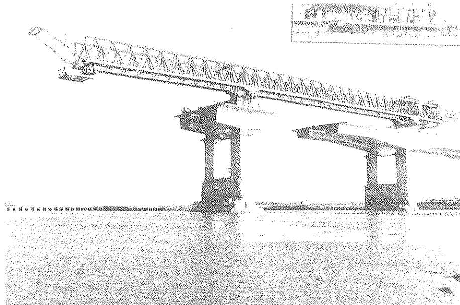
Fig. 9. 2º Puente de Severn.
