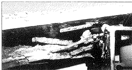
Detalle de fallo de la soldadura de la malla a los pernos de anclaje.
