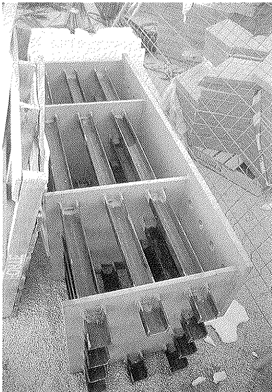
Fig. 12. Base de estribo, con armazón de anclaje.
