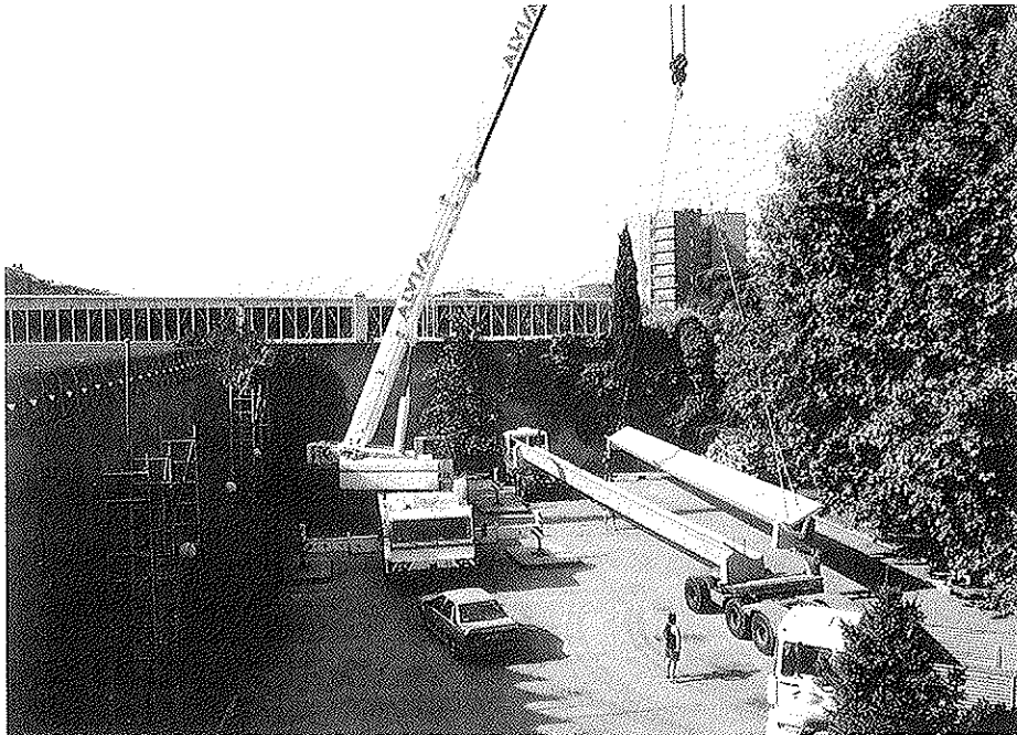
Foto 11. Descarga de vigas en obra. Cada Dolly transportaba 2 vigas, simultáneamente. El apoyo se efectúa mediante elementos diafragma en sus extremos.
