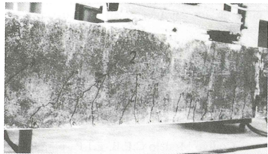
Foto 6. Viga 2 (escalón de rotura nominal).
