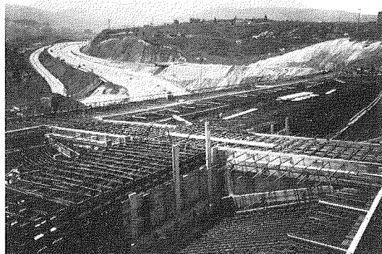
Fig. 24. Detalle del armado del tablero del puente 1.
