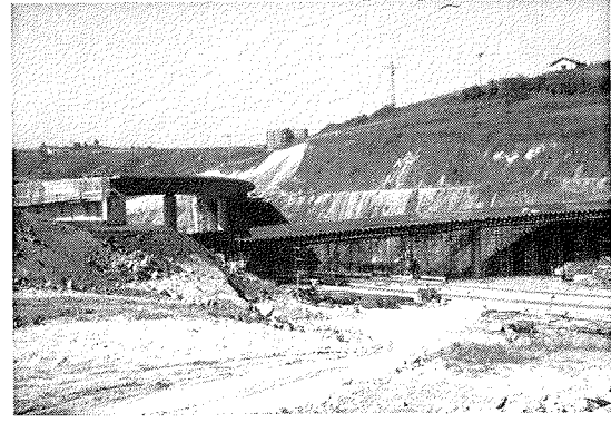
Fig. 28. Puente 1 descimbrado y vista de la cimbra y encofrado del tablero del puente 2.
