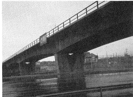
Fig. 16. Otro aspecto de la estructura terminada.
