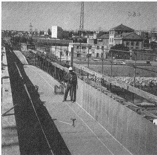
Fig. 6. Vista del encofrado exterior.
