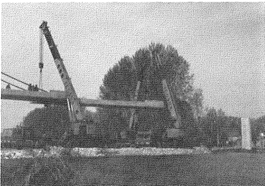
Montaje viga en vano atirantado,
