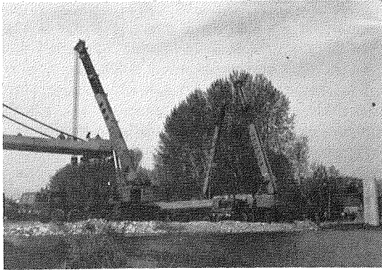
Montaje viga en vano atirantado.
