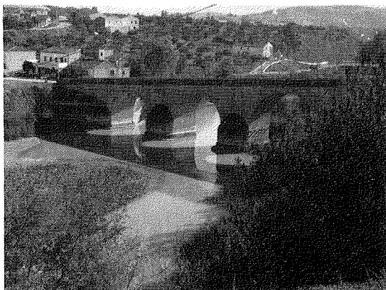
Fig. 45. Vista del puente existente.
