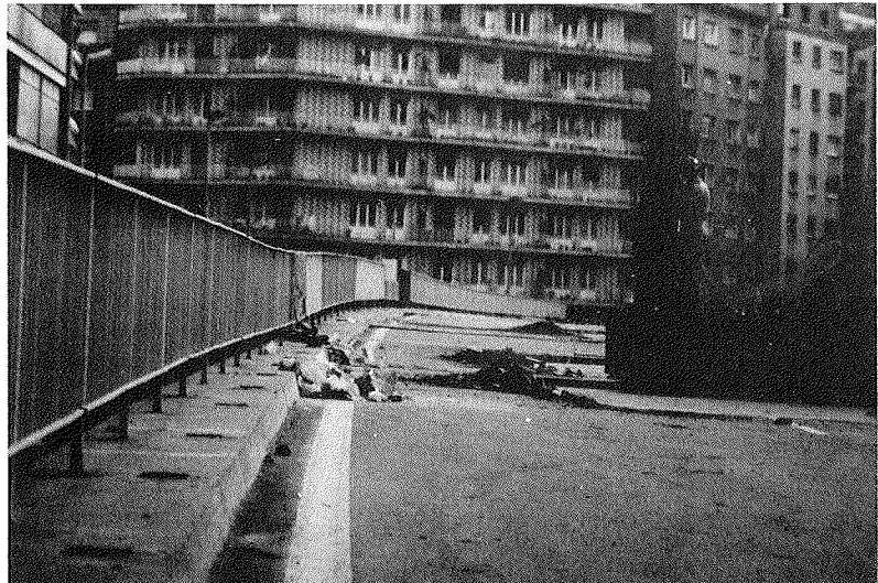
Fig. 7.17. El quiebro existente en la barandilla, da una idea gráfica de las flechas alcanzadas.
