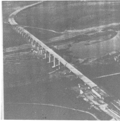
Fig. 8. Casale Monferrato. Vista general.
