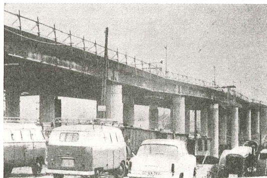
Fig. 30. —Aspecto de la obra del puente de Liedbachtal antes del pretensado y bloqueo de las juntas. Puede apreciarse la curvatura en la zona central del puente.
