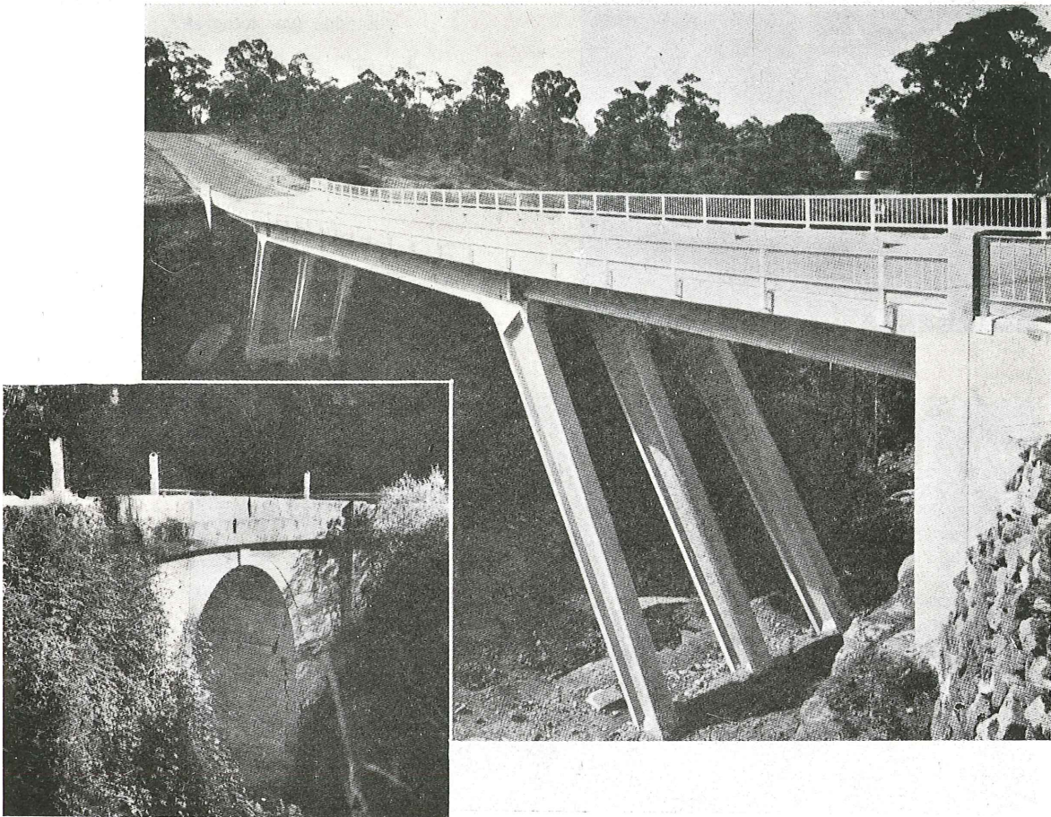
Fotografía 1: El nuevo puente de Lapstone, terminado. — Fotografía 2: A sólo unos pocos kilómetros de distancia del nuevo puente se encuentra ubicado el de Lennox, que es el más antiguo de los que aún subsisten en todo el continente australiano. Construido en piedra en 1833, para la carretera principal del Oeste, está constituido por un solo arco de 6 m. de luz.
