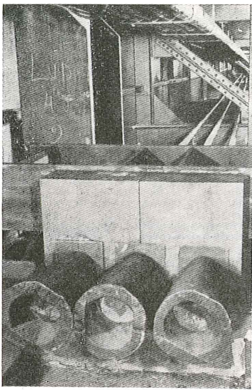
Fig. 7. — Anclajes de mazarota.
