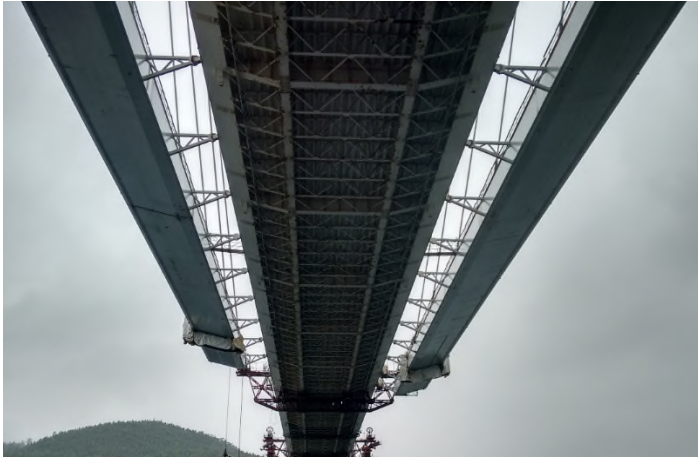
Figura 18. Vista inferior del tablero original durante la construcción de la ampliación.
