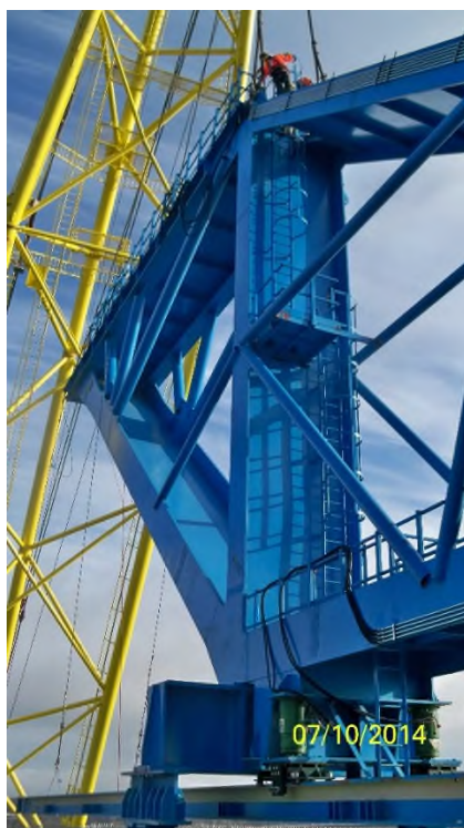
Figura 13. Carro izado dovelas. Queensferry Crossing.
