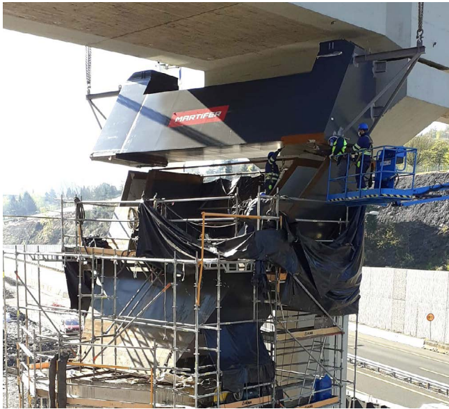
Figura 19. Montaje de dovela 4.
