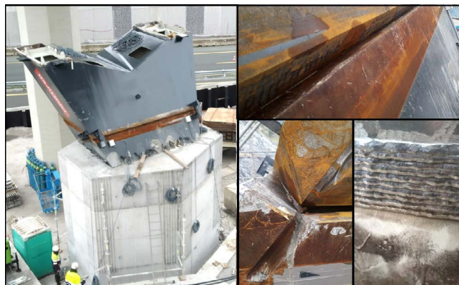
Figura 18. Montaje de dovela 2. Espesores de chapa y uniones soldadas.
