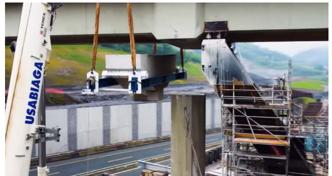
Figura 24. Retirada del dintel de la pila original.
