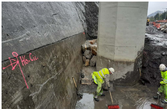
Figura 14. Excavación y limpieza para ejecución de la cimentación.
