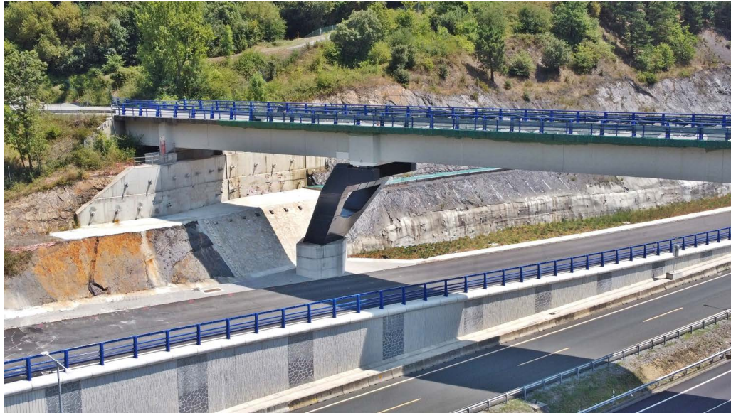
Figura 5. Vista lateral de la pila.
