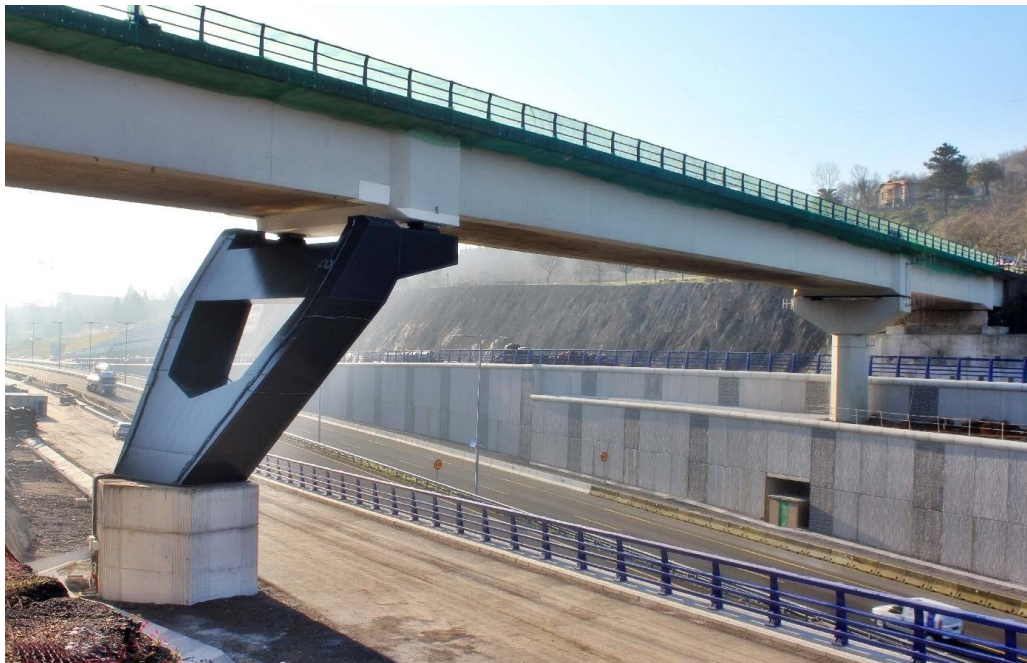
Figura 6. Vista trasera de la estructura.
