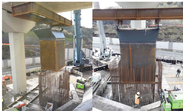
Figura 16. Montaje de dovela 1.
