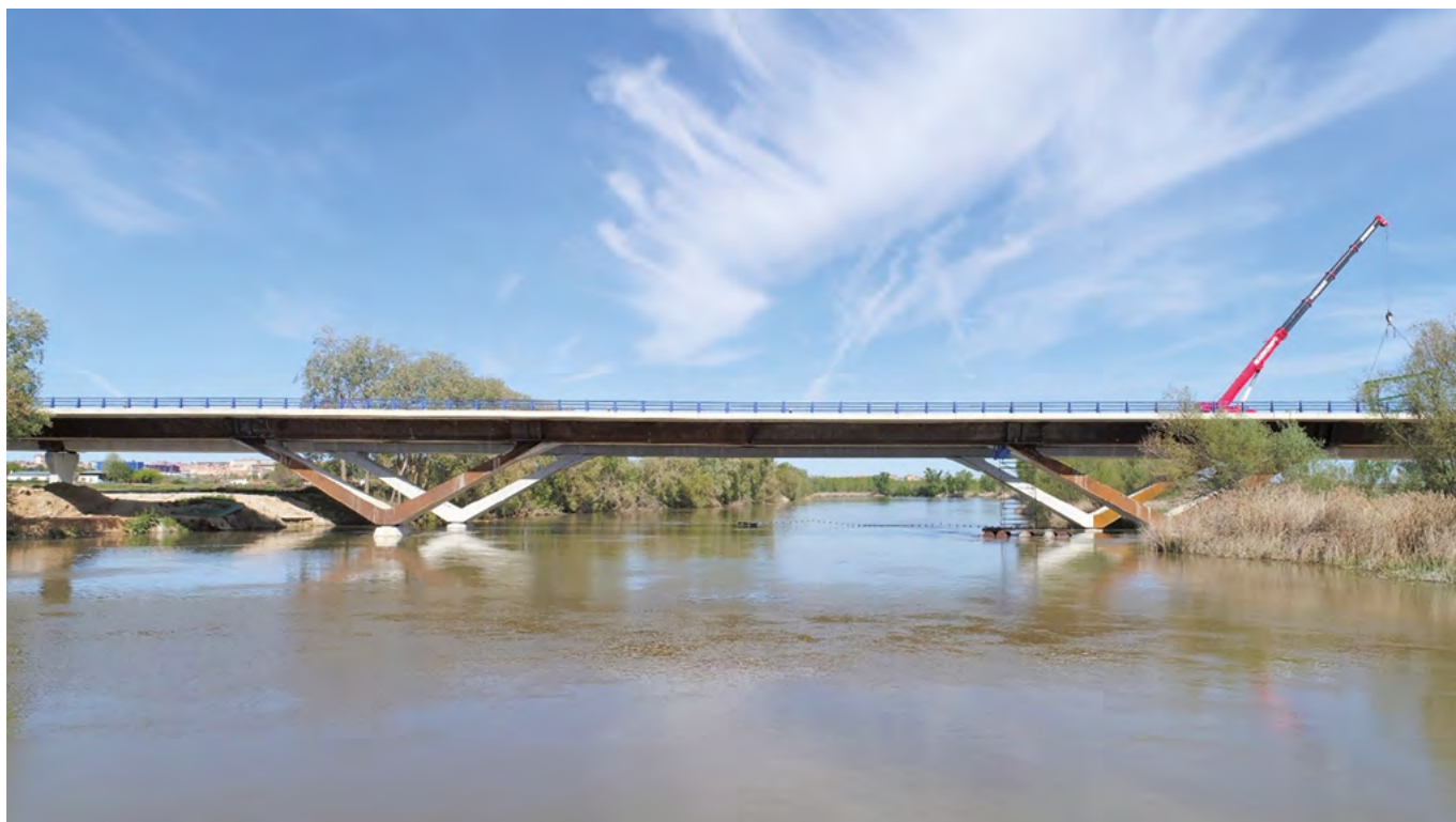
Figura 35. Vista del nuevo puente mixto tras las obras de reparación.
