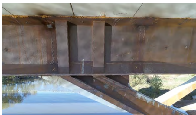
Figura 33. Vista de las pilas en V.
