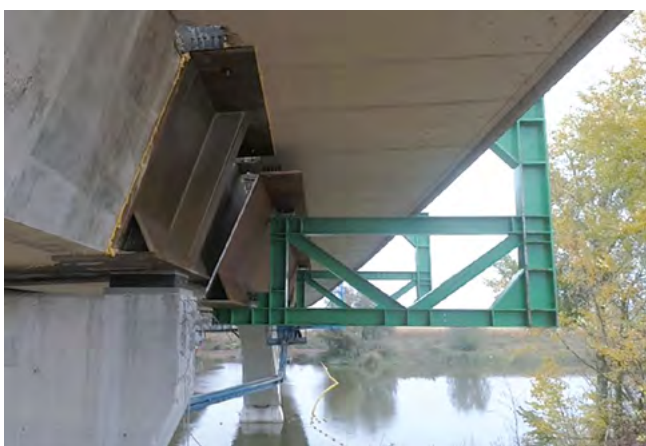
Figura 29. Montaje de dovelas.
