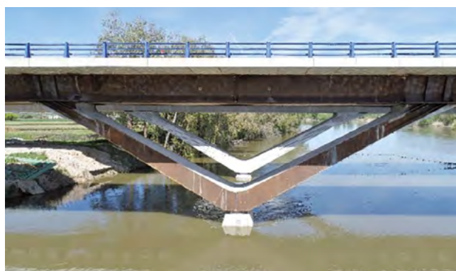
Figura 34. Vista del nudo de las pilas en V.
