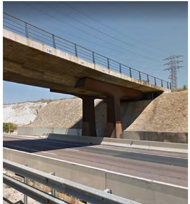
Figura 8. Ampliación de luces en paso superior mediante pescante metálico.
