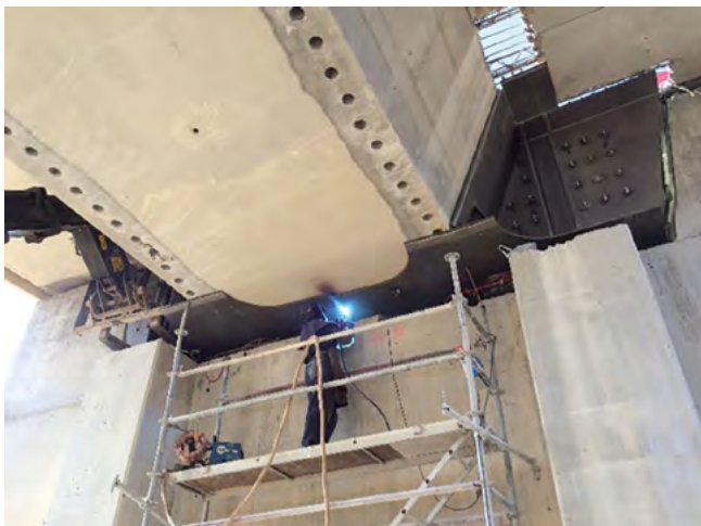
Figura 21. Montaje de dovelas de estribo y ejecución de soldadura de conexión in situ .
