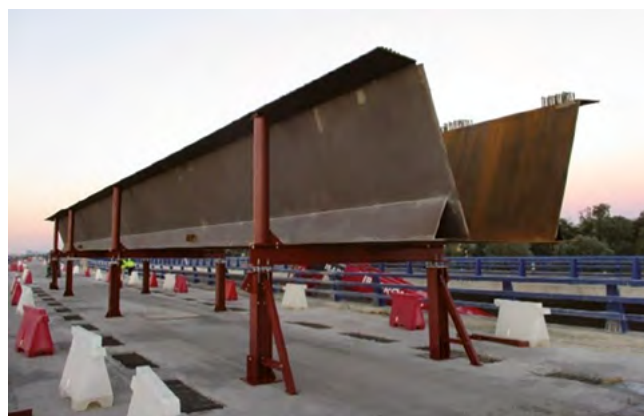
Figura 23. Dovelas sobre la plataforma listas para su montaje.
