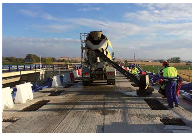
Figura 30. Hormigonado de las ventanas ejecutadas en los voladizos para alojar la conexión superior.
