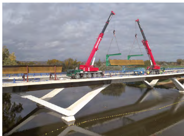
Figura 28. Montaje de dovelas.
