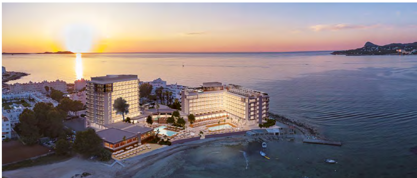
Figura 40. Los edificios rehabilitados.
