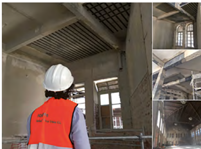
Figura 25. Refuerzos de fibra de carbono en estructura de torreones. (foto cortesía de Solurban).
