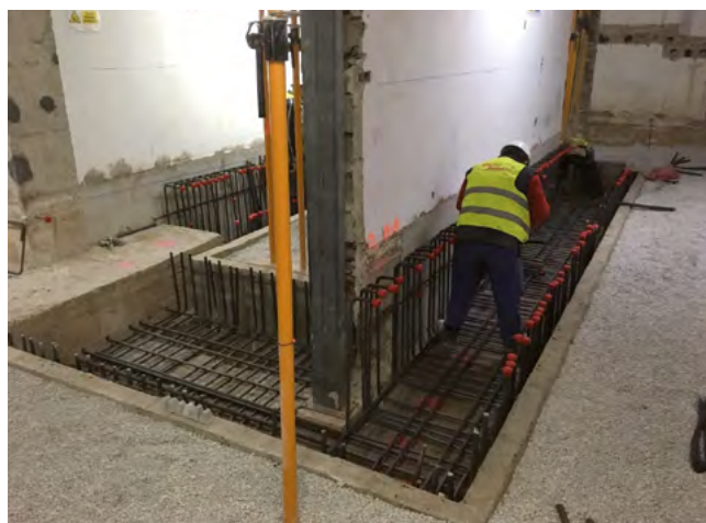
Figura 34. Armado de encepado (ejecución en 2 fases).
