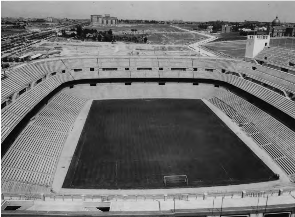
Figura 1. Foto del estadio desde el sur, en 1955. En la mayoría del estadio se observan dos anfiteatros. Cortesía de la biblioteca de la Facultad de Empresa y Gestión Pública. Universidad de Zaragoza.
