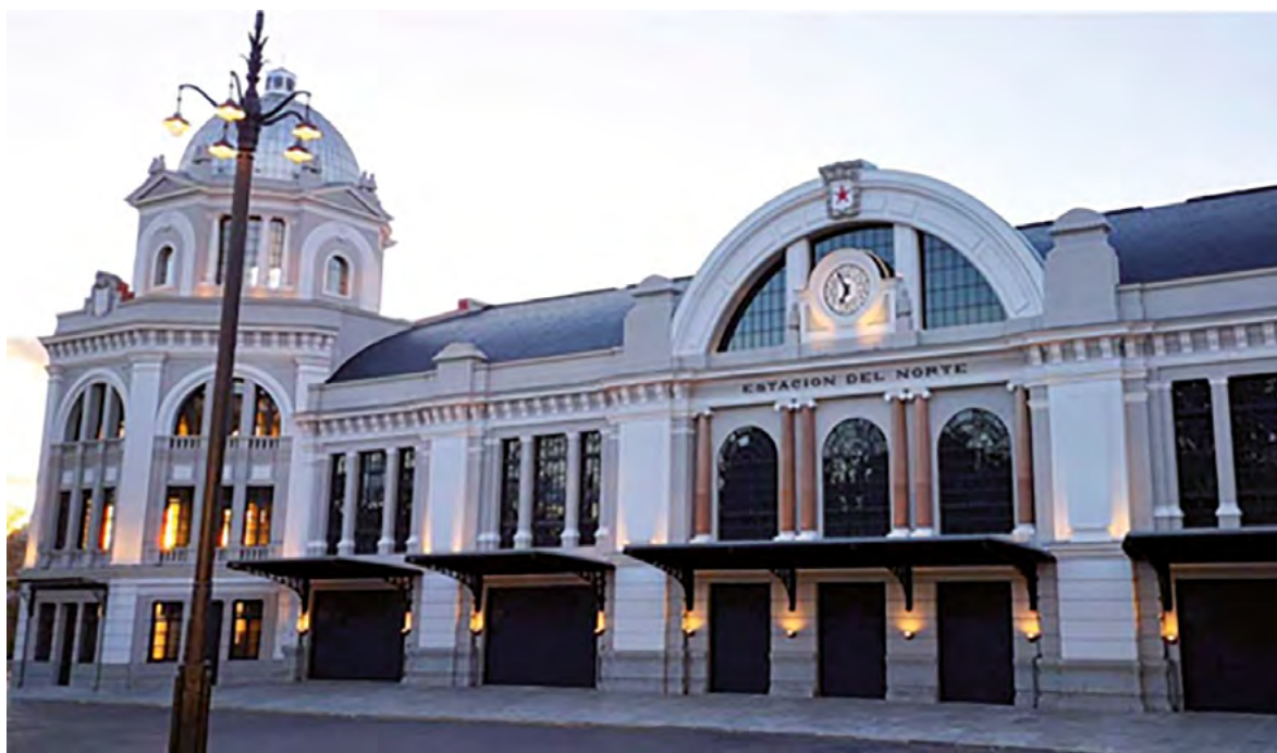
Figura 27. Parte central de la fachada sur tras la restauración, con el nuevo reloj y las marquesinas (cortesía de Solurban).
