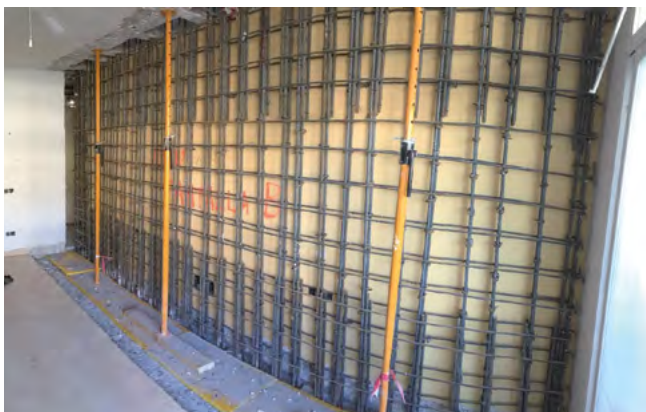
Figura 32. Armado de pantalla adosada a cerramiento existente.
