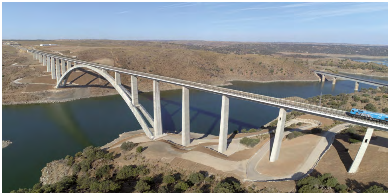
Figura 4. Vista general del viaducto de Almonte. (Fuente: Adif).
