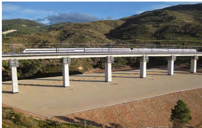
Figura 5. Vista general del viaducto de Pont Candí (Fuente: Adif).
