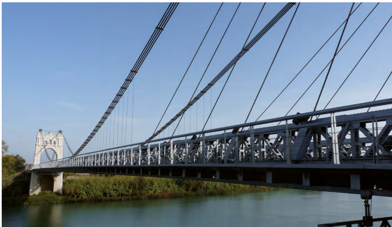
Figura 3. Vista longitudinal del puente de Amposta rehabilitado.
