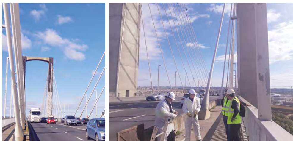
Figura 8. Detalle puente atirantado del Centenario (izquierda). Acceso para inspeccion del interior del tablero (derecha).
