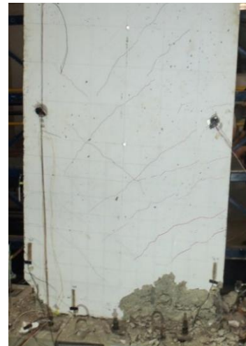
Figura 4. Estado final del muro M0R10.
