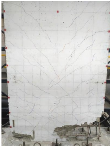
Figura 6. Estado final del muro M1R10.
