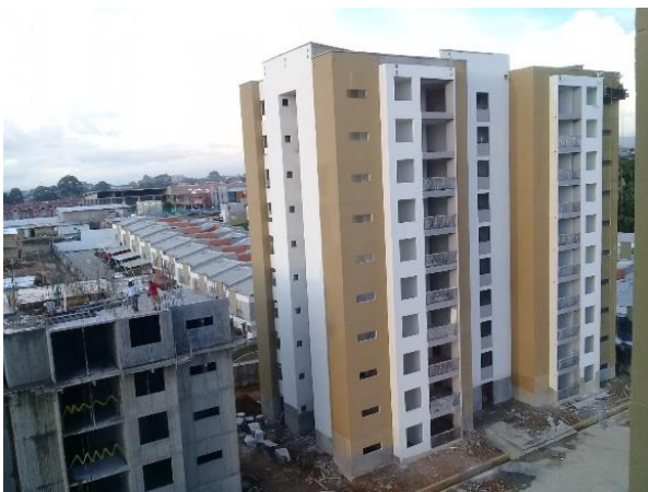
Figura 1. Edificios de muros delgados de concreto reforzado.
