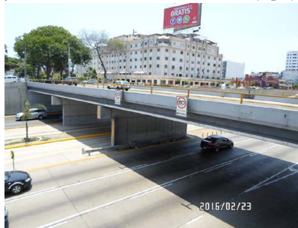
Figura 2. Ejemplo de puente existente.
