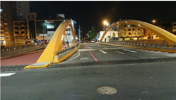
Figura 17. Ambos puentes terminados.
