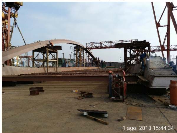
Figura 10. Montaje en taller metálico (Junín).
