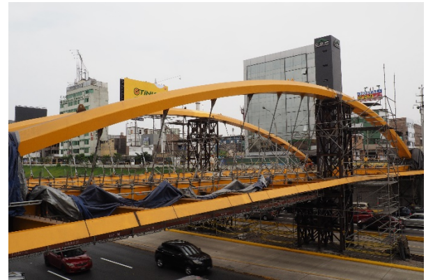
Figura 15. Estructura metálica completada en ambos puentes (Leoncio Prado y Junín respectivamente).
