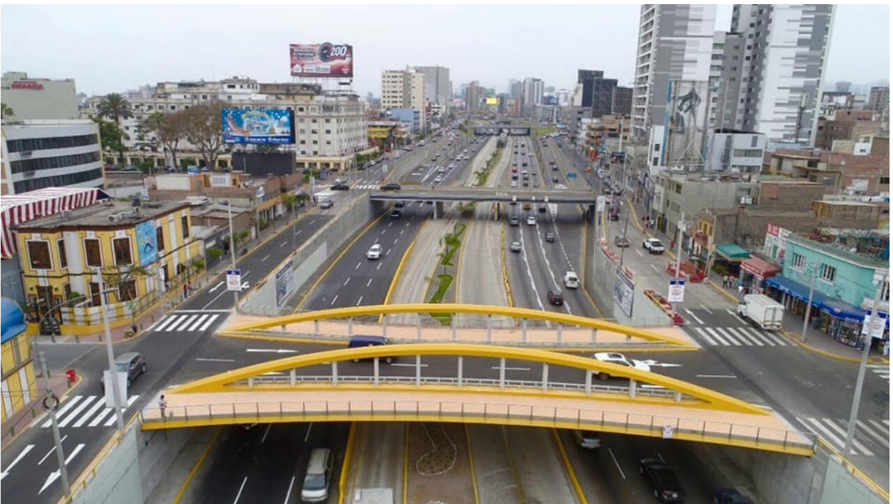
Figura 18. Puente Leoncio Prado en servicio.
