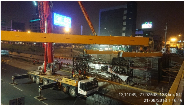
Figura 13. Izado de viga (Junín).
