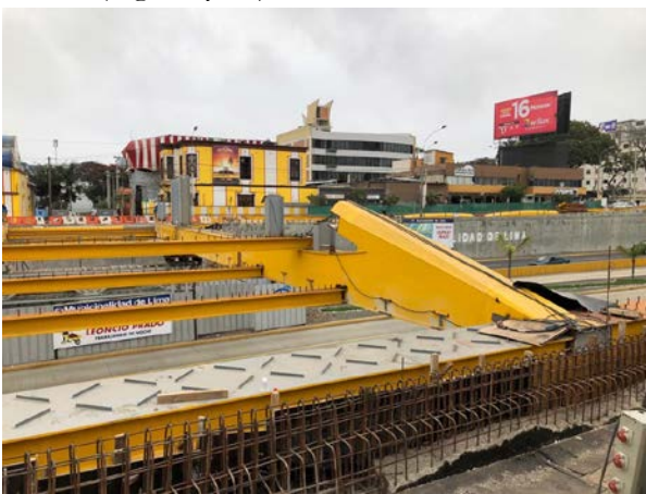
Figura 14. Montaje de la estructura metálica (Leoncio Prado).
