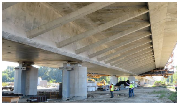
Figura 10. Vista inferior del tablero
