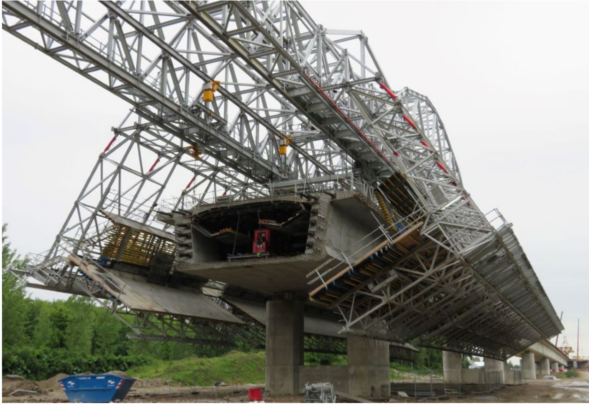
Figura 8. Vista general durante la construcción, en el momento de desencofrado de una fase de cajón central.
