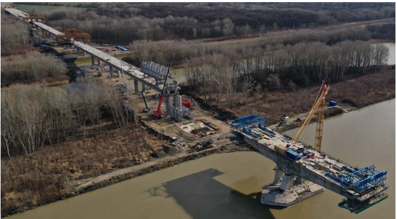
Figura 12. Paso de la autopista D4 sobre el río Danubio. Vista general durante la construcción del viaducto de acceso este y de parte del puente sobre el Danubio, ambos diseñados por Torroja Ingeniería, SL.
