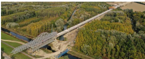
Figura 1. Vista aérea del Viaducto de Acceso Este durante su construcción.
