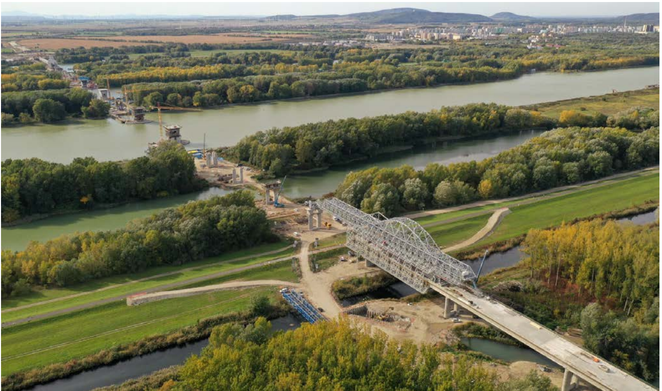
Figura 11. Paso de la autopista D4 sobre el río Danubio. Vista general durante la construcción, desde el acceso este.
