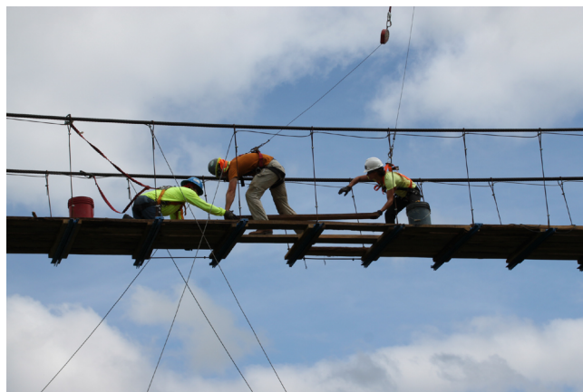
Figura 13. Instalación de las vigas longitudinales en el tablero.
