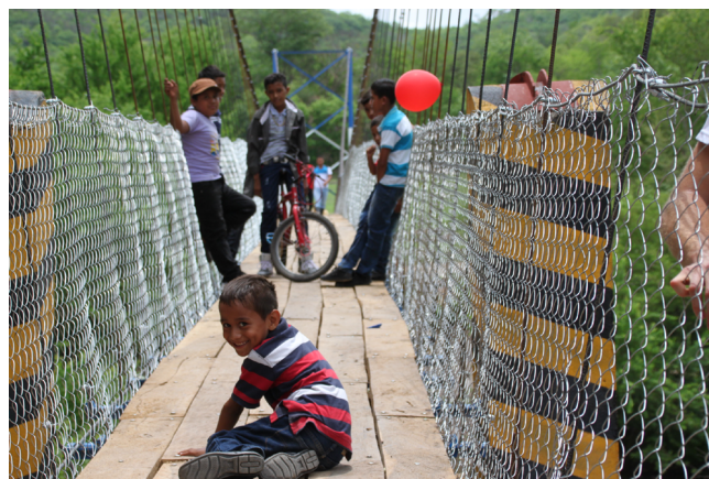
Figura 17. Vista desde el tablero de la pasarela Monte Verde terminada.
