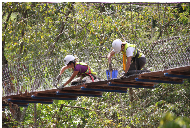
Figura 14. Instalación de la malla metálica de protección en la Pasarela San Vicente.
