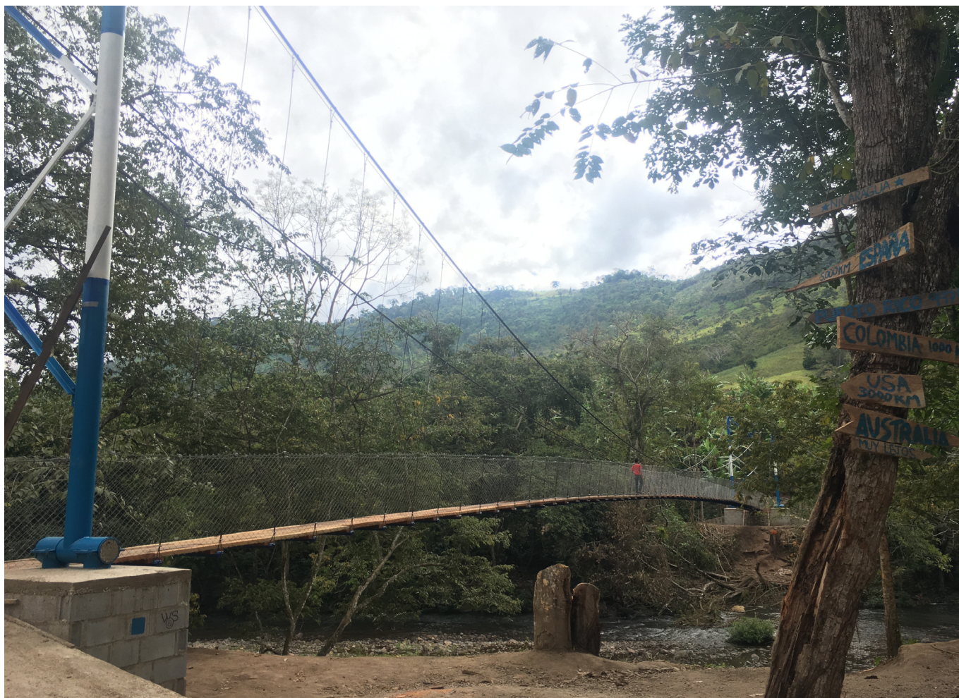
Figura 18. Vista lateral de la Pasarela San Vicente terminada.
