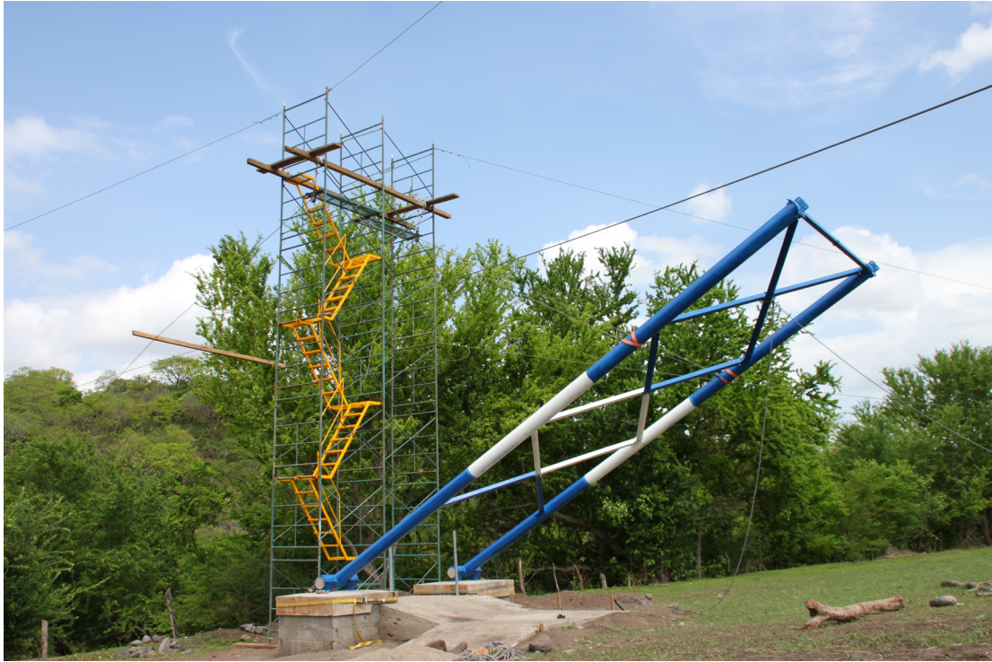
Figura 10. Izado de una de las torres de la pasarela Monte Verde.
