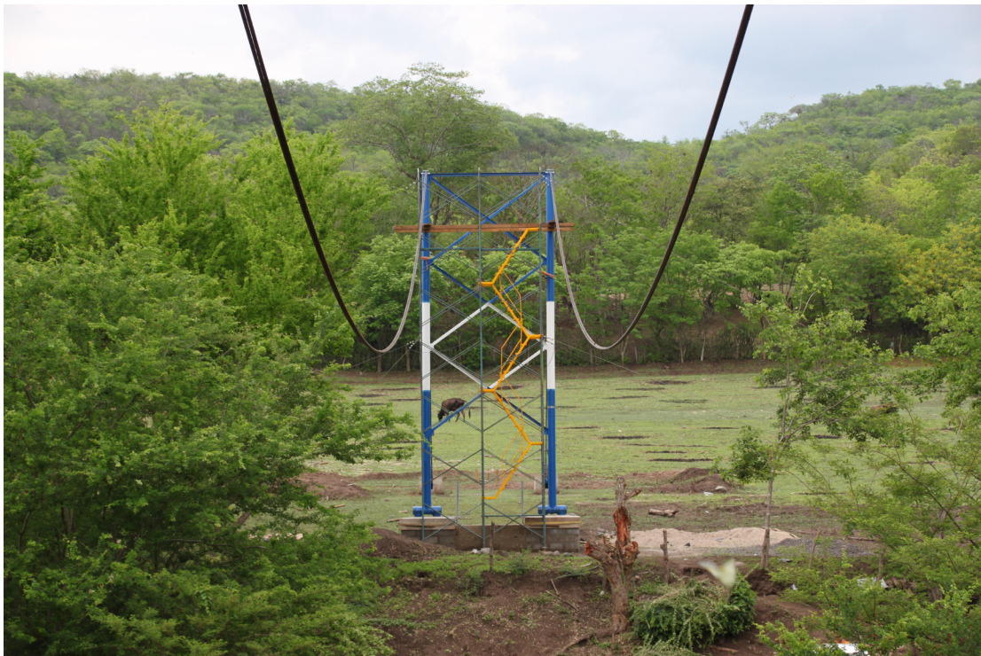
Figura 11. Vista de los cables principales desde una de las torres en la pasarela Monte Verde.
