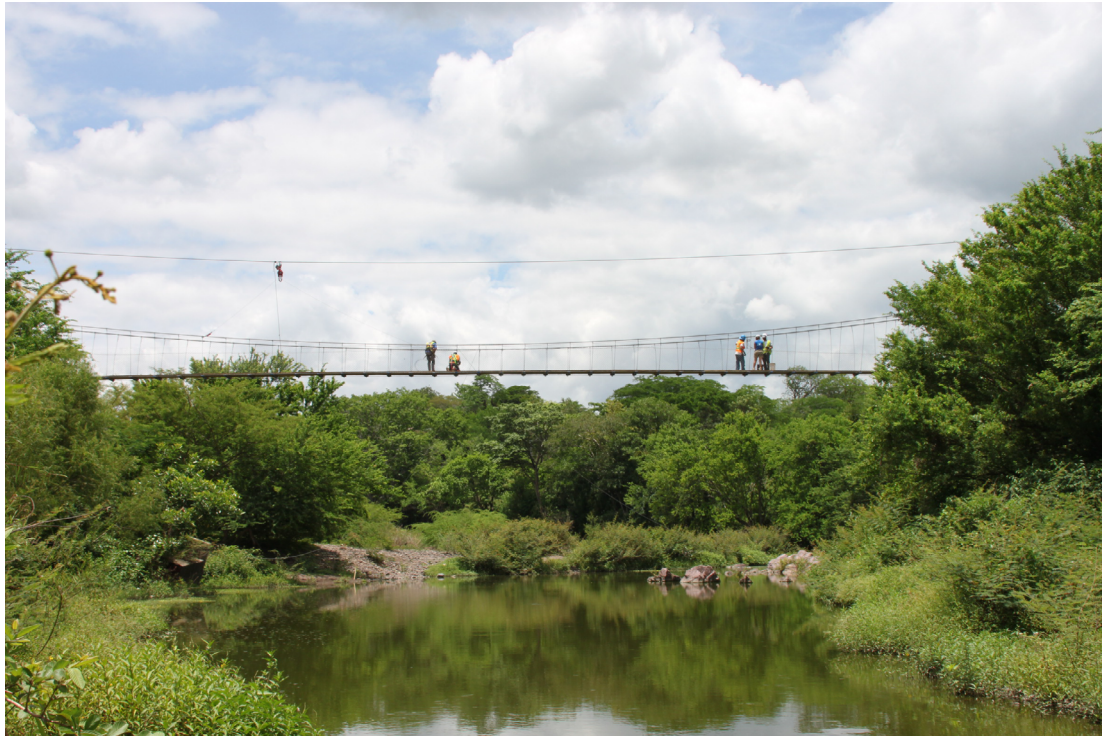
Figura 9. Alzado de la pasarela Monte Verde durante las etapas finales de construcción.
