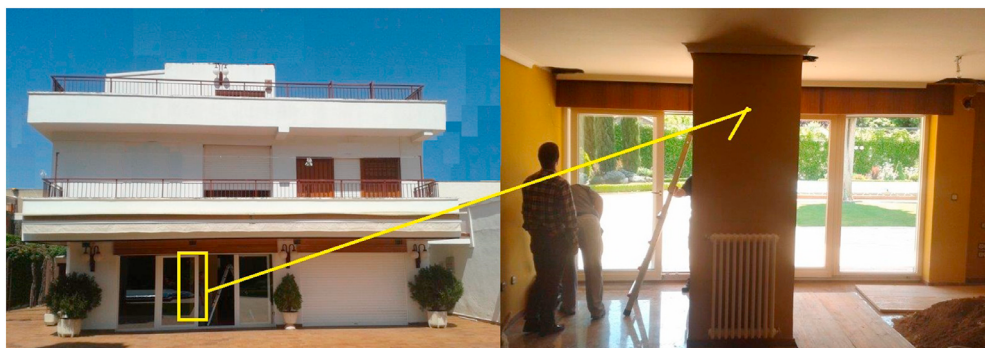
Figura 6. Edificio y localización del soporte a eliminar.
