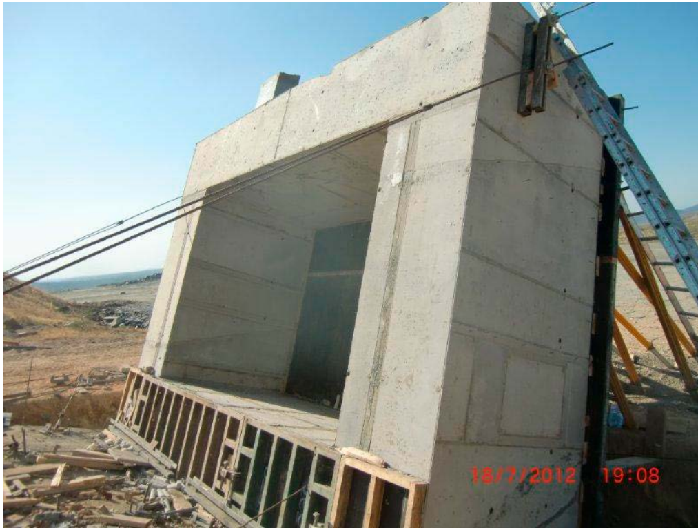
Figura 10. Dovela de prueba desencofrada.
