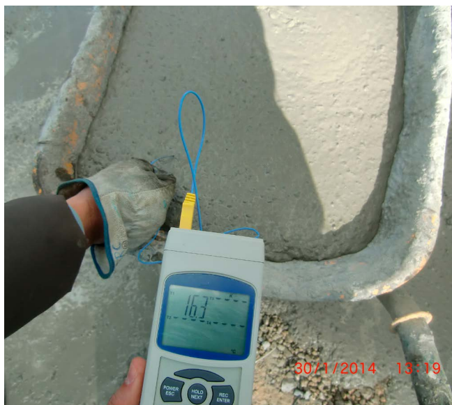
Figura 7. Toma de temperaturas de fraguado de hormigón fresco.
