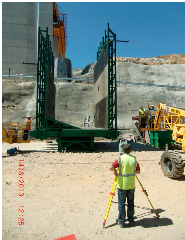
Figura 2. Control geométrico de encofrado.
