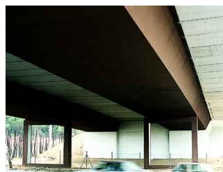
Figura 34. Paso sobre la A-2 c/ Marqués de Suanes (Madrid).
