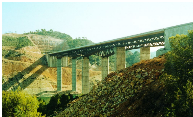
Figura 58. Viaducto de Contreras (Valencia).
