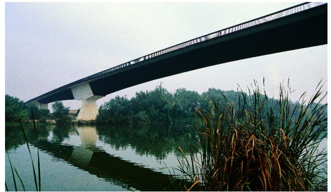
Figura 12. Puente de Tortosa (Tarragona).
