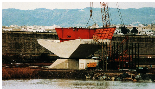
Figura 53. Ejecución de la zona de célula elástica.
