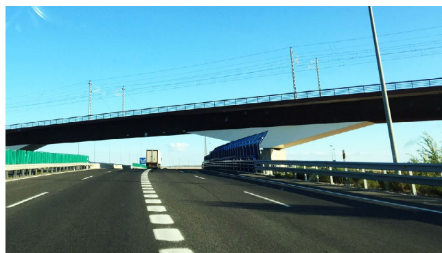
Figura 18. Puente para el AVE sobre la A-31 (Albacete).
