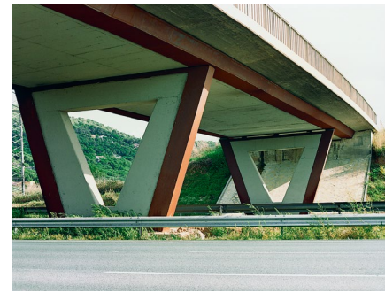
Figura 49. Paso superior con cajón muy ancho sobre hormigón.
