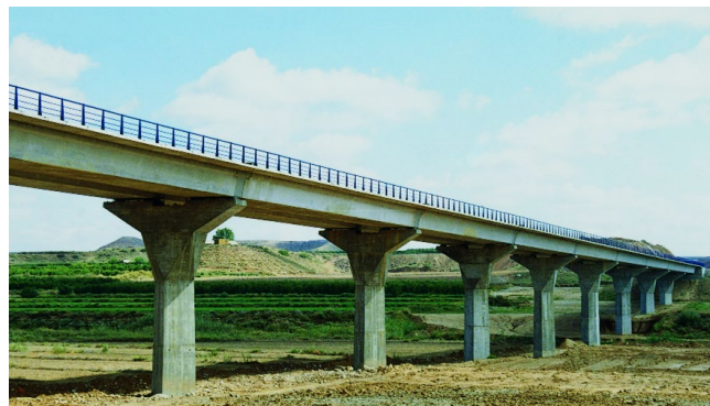
Figura 52. Viaducto de La Clamor, L.A.V. Madrid-Barcelona.
