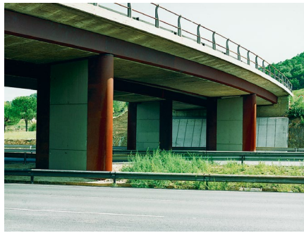
Figura 48. Paso superior con doble cajón de hormigón.
