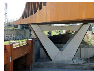
Figura 39. Puente para AVE c/Comercio (Madrid).
