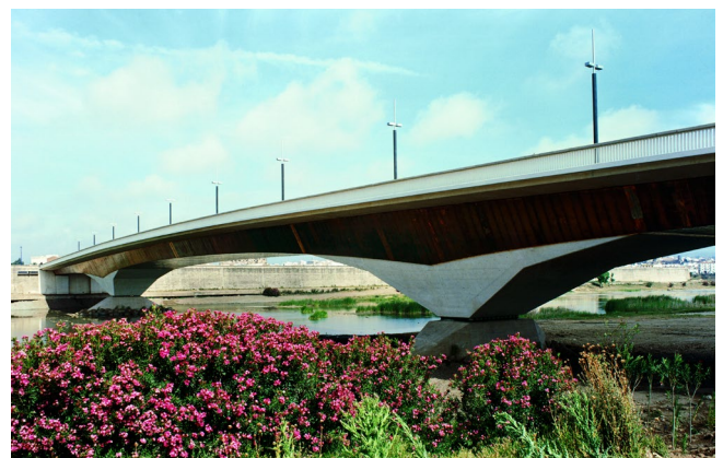
Figura 14. Puente del Arenal sobre el río Guadalquivir (Córdoba).
