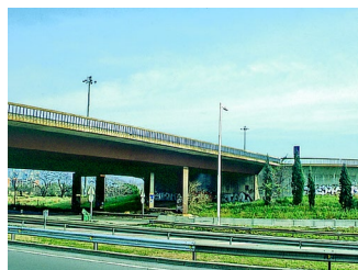
Figura 37. Puente de Sant Adria (Barcelona).
