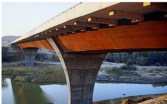
Figura 15. Puente de Mengibar sobre el río Guadalquivir en la Autovía Bailén-Jaén.
