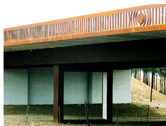
Figura 33. Paso sobre la A-2 c/ Marqués de Suanes (Madrid).
