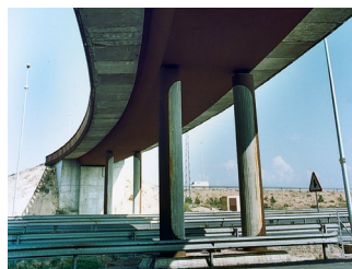
Figura 38. Puentes E-23 y E-25 (Valencia).
