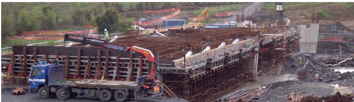
Figura 13. Vista de cimbra y tablero.
