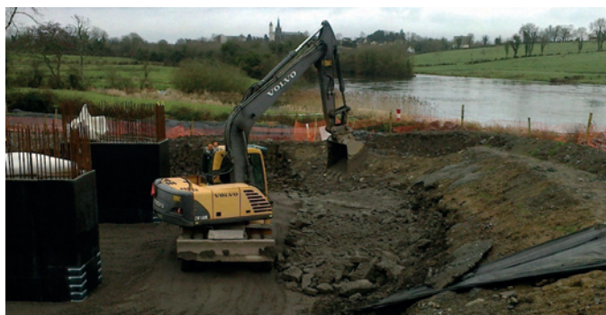
Figura 10. Estribo norte en ejecución.
