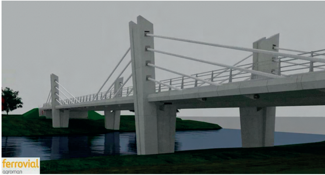
Figura 6. Inclinación de los tirantes.
