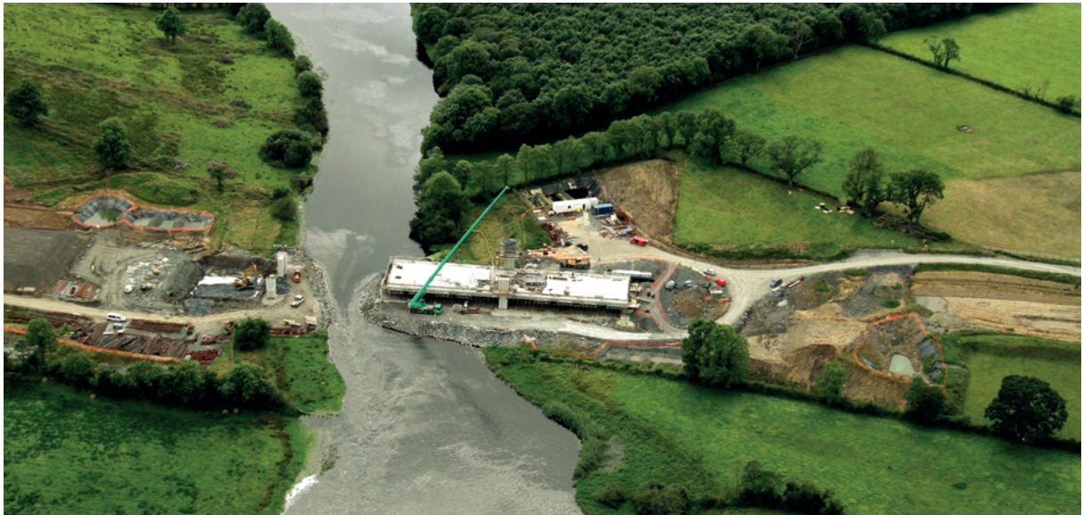
Figura 15. Vista aérea de la construcción del lado norte.
