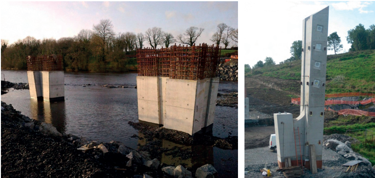
Figura 12. Vista de los pilonos en ejecución.
