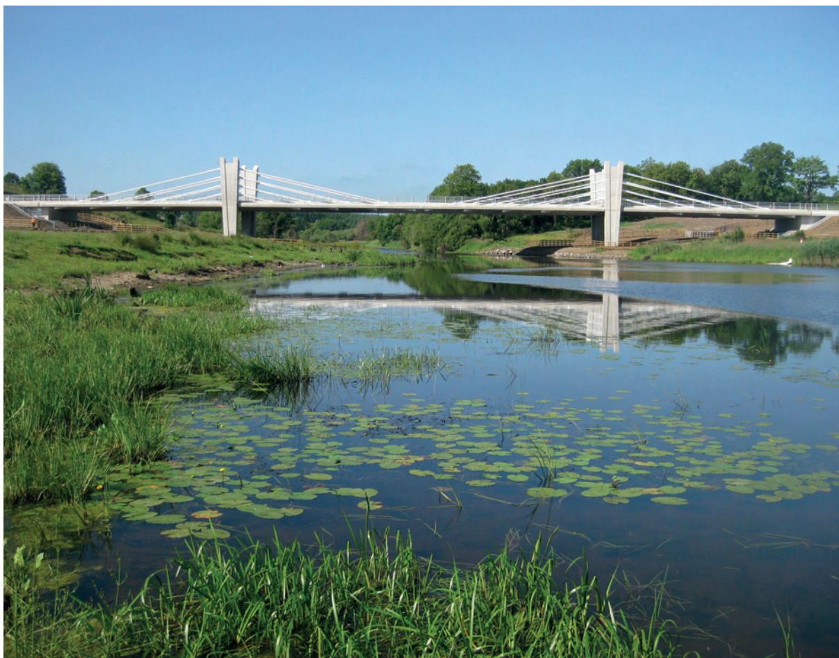
Figura 18. Acabado final del puente.
