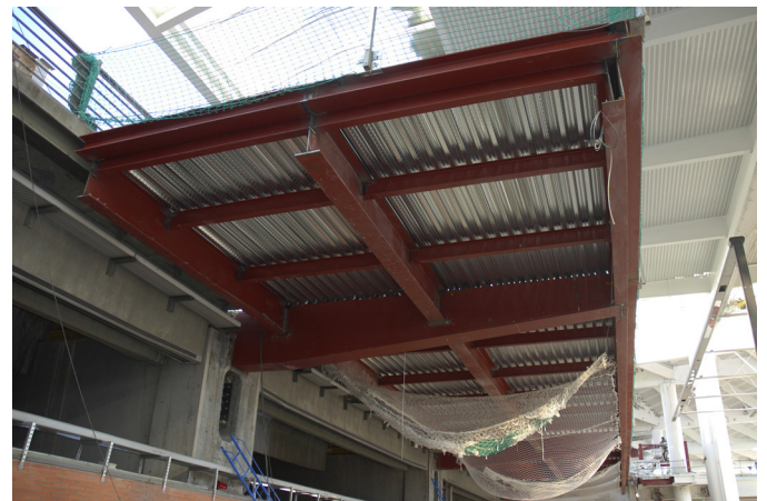
Figura 28. Vista del voladizo by-pass desde las vías del AVE.
