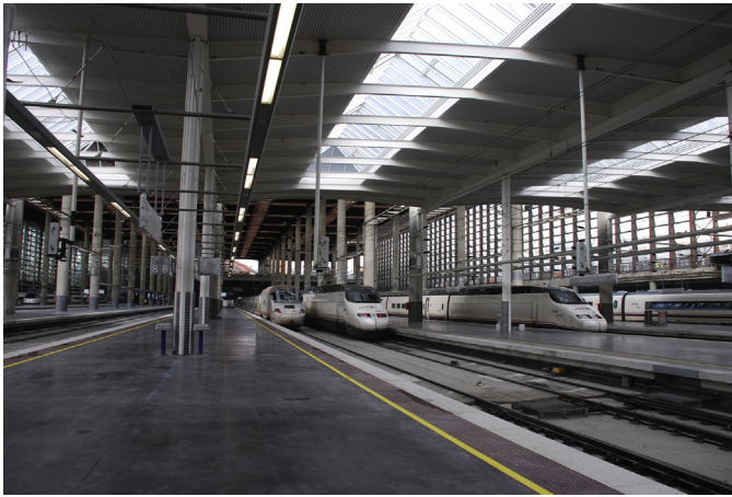
Figura 4. Cubierta baja norte.
