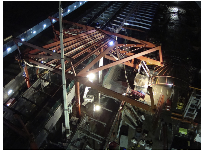
Figura 52. Montaje del primer módulo de la cubierta alta.
