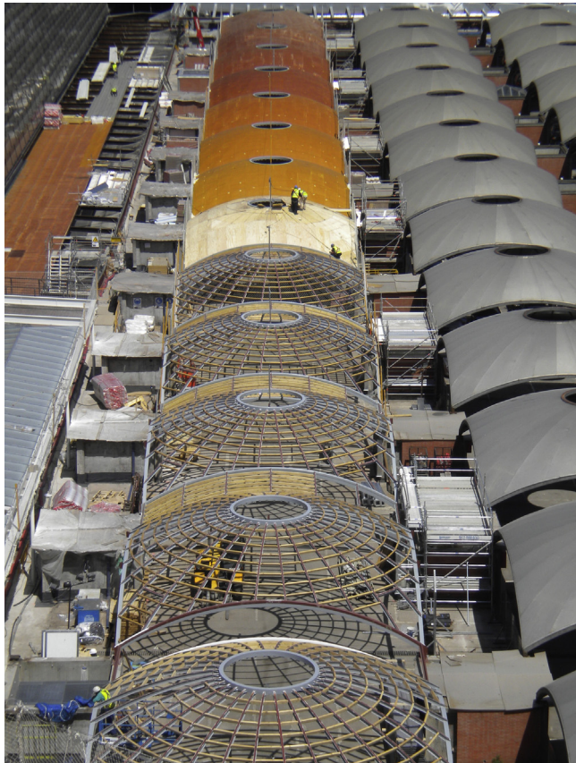
Figura 8. Vista de las cúpulas que cubren el pasillo rodante, durante la ejecución de las obras.
