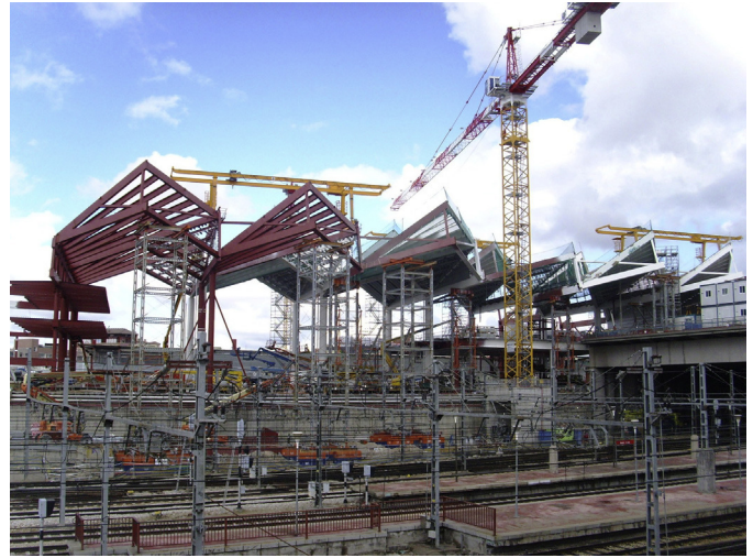
Figura 53. Torres de apeo sobre cercanías.
