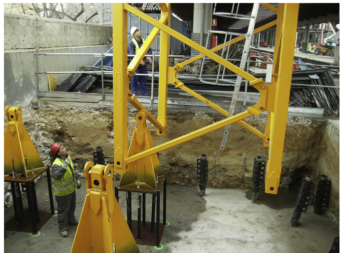
Figura 49. Montaje de la grúa del andén 8.
