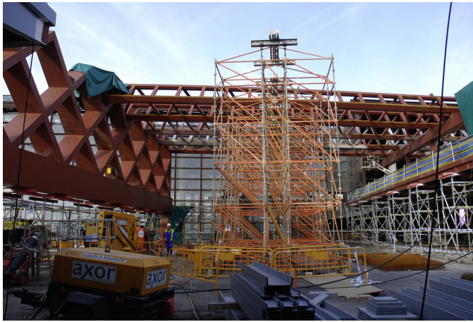
Figura 57. Montaje de la cubierta por módulos.
