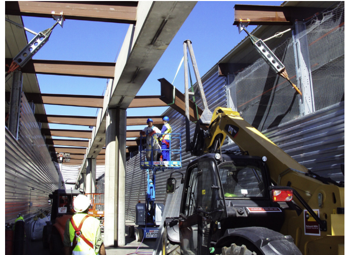
Figura 41. Demolición de las marquesinas existentes entre túneles provisionales para la protección de vías.
