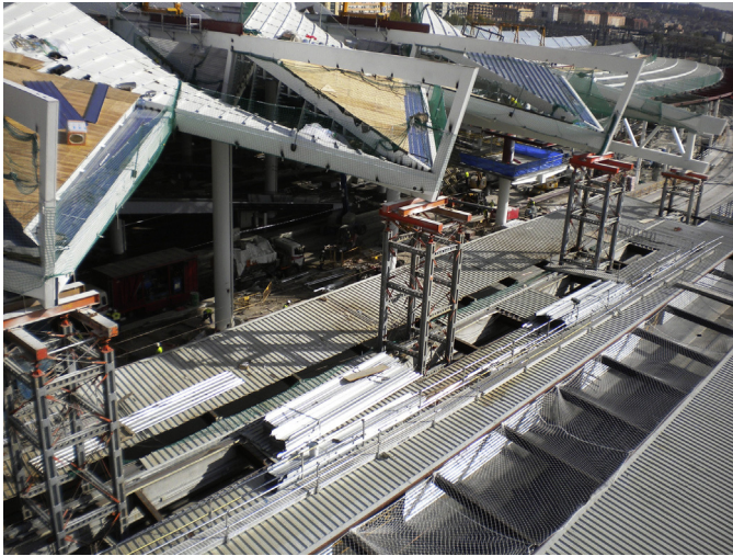
Figura 54. Torres de apeo en andén 7.
