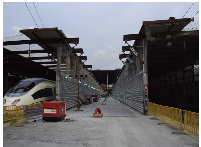
Figura 36. Túneles provisionales para la protección de vías.
