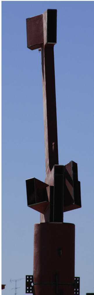
Figura 18. Nudo de cubierta alta durante el montaje.
