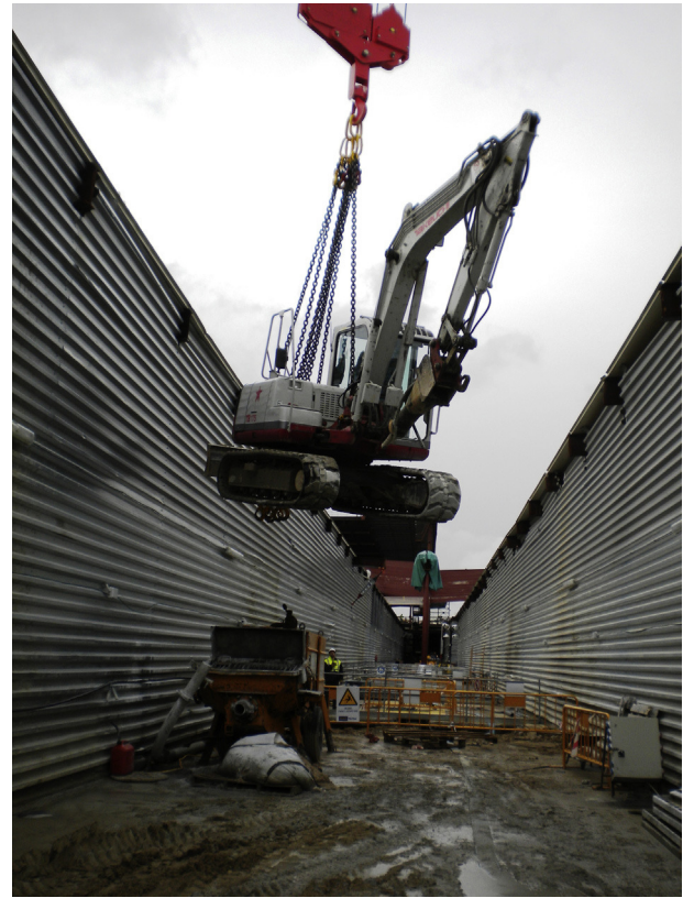
Figura 45. Acceso de maquinaria a los andenes.
