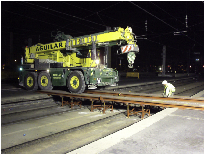
Figura 46. Tránsito de maquinaria entre andenes.
