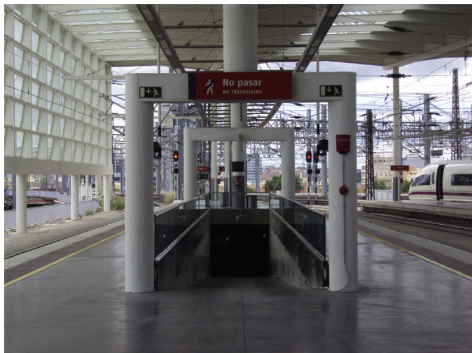
Figura 10. Rampas de catering, aspecto terminado.
