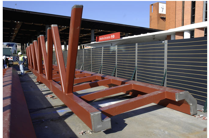
Figura 58. Módulo de cubierta a pie de obra.
