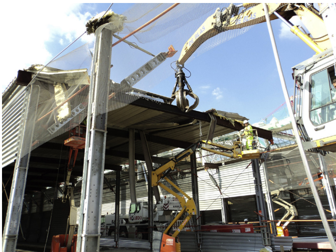
Figura 44. Demolición de los túneles provisionales.
