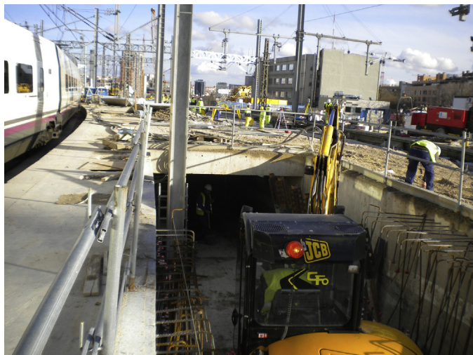
Figura 9. Rampas de catering durante la ejecución.
