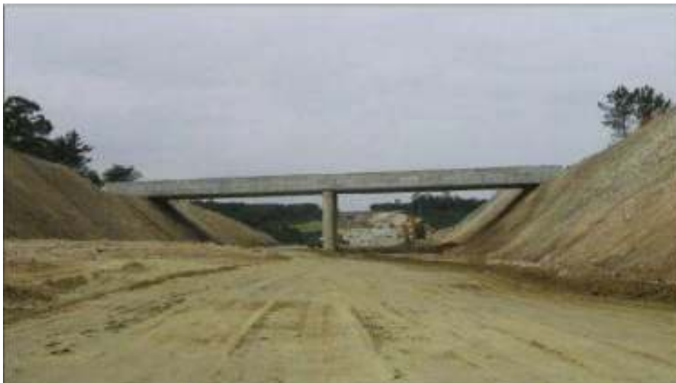
Figura 18. Estado tras la excavación.
