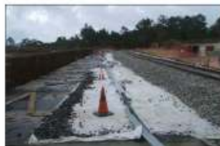
Figura 12. Ejecución de vigas peraltadas con vía en servicio. Impermeabilización bajo balasto.
