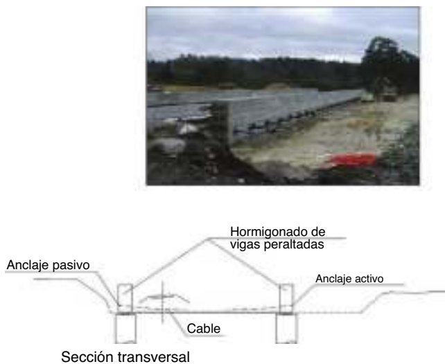
Figura 14. Hormigonado de vigas peraltadas.
