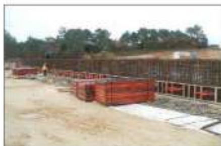
Figura 12. Ejecución de vigas peraltadas con vía en servicio. Impermeabilización bajo balasto.
