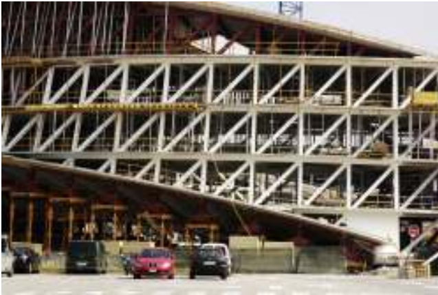
Figura 8. Vista lateral de la celosía exterior durante la ejecución del forjado de cubierta. Obsérvese cómo las diagonales mantienen su directriz recta en los encuentros con los forjados de fondo y cubierta.
