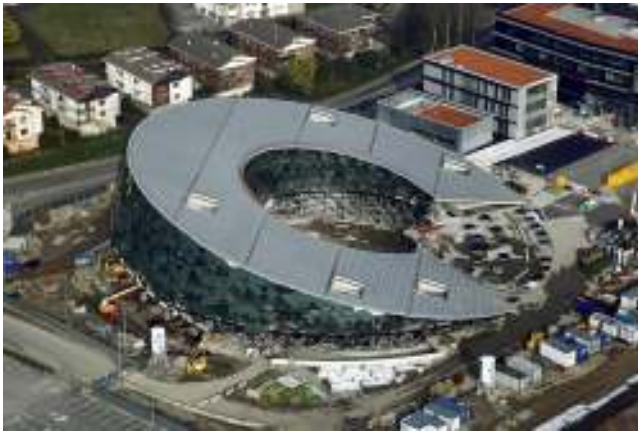
Figura 4. Vista superior de la cubierta.
