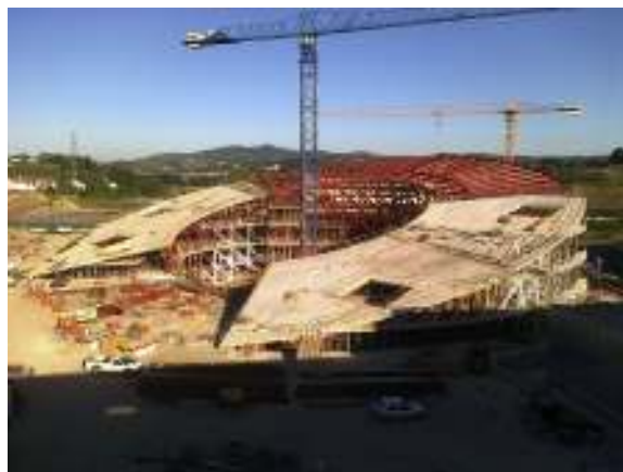
Figura 11. Ejecución del forjado de cubierta.
