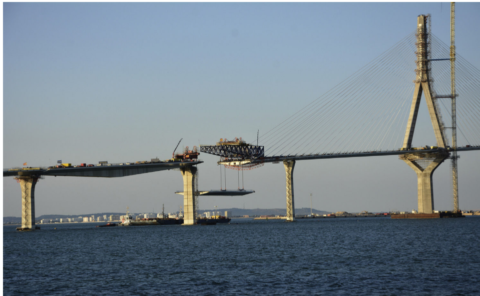
Figura 7. Cierre lateral con el puente desmontable.
