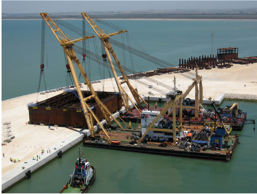
Figura 3. Carga del recinto estanco para la cimentación del pilono situado en el mar.
