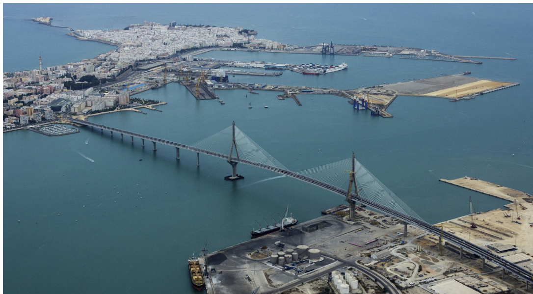
Figura 13. Vista general del puente.
