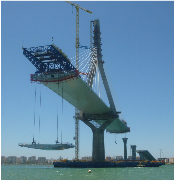
Figura 6. Operación de izado de una dovela típica.
