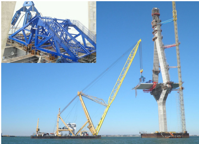
Figura 10. Elemento especial para colocación de dovelas iniciales.
