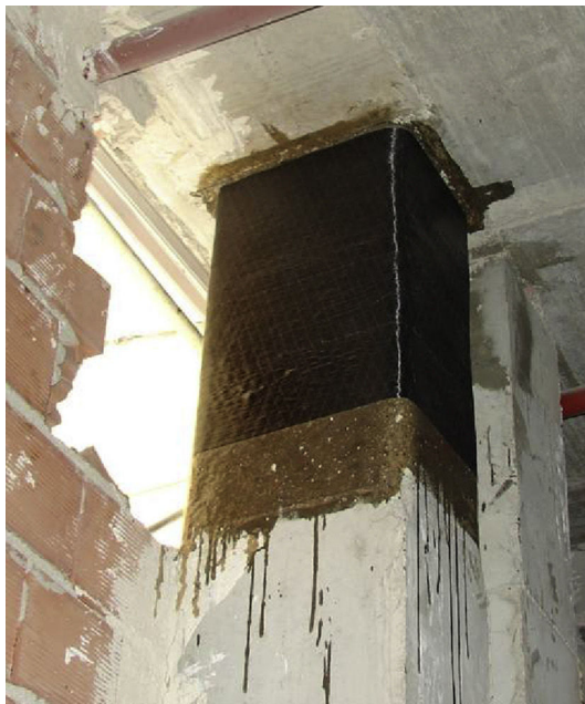
Figura 5. Actuaciones en cabeza de soportes (fotos tomadas en Lorca).
