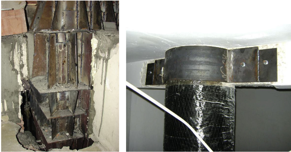
Figura 2. Ejemplos de actuaciones en nudos para encamisado y zunchado de pilares (fotos tomadas en Lorca).
