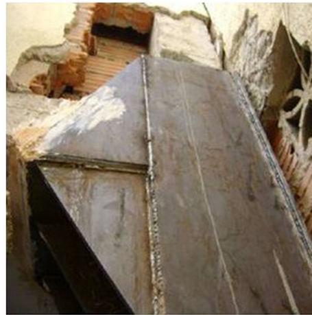
Figura 10. Detalle de refuerzo de capitel [8].
