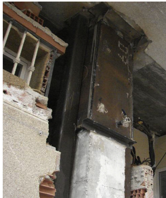
Figura 5. Actuaciones en cabeza de soportes (fotos tomadas en Lorca).
