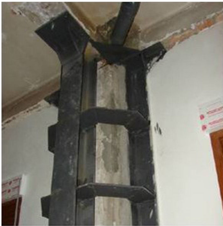
Figura 10. Detalle de refuerzo de capitel [8].
