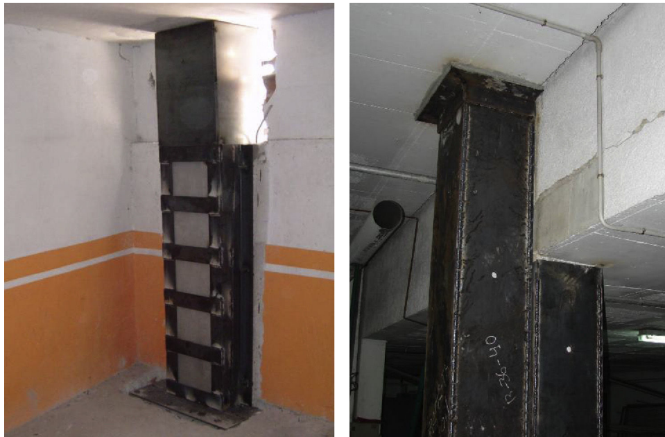
Figura 3. Zunchado y empresillado parcial sobre tramo de pilar dañado (fotos tomadas en Lorca).
